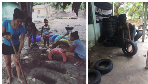
Imagem 12 e 13 – Construção da passarela e limpeza de pneus
