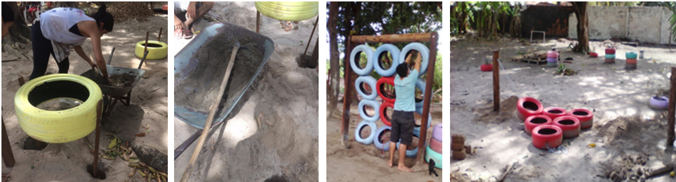
Imagem 14 e 15 – Utilização da técnica do solo cimento
