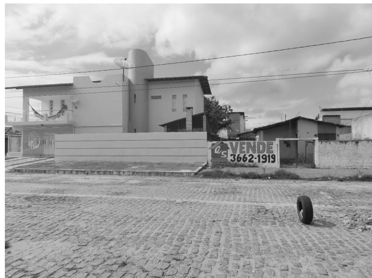
Imagem 1 - Casa reformada e casa padrão, Conjunto Soledade
