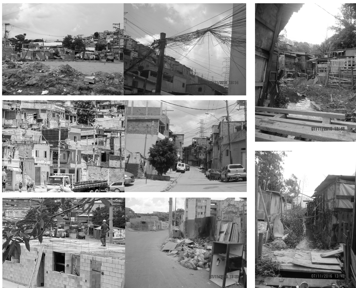
Imagem 6 - Imagens da situação atual da Colinas D'Oeste
