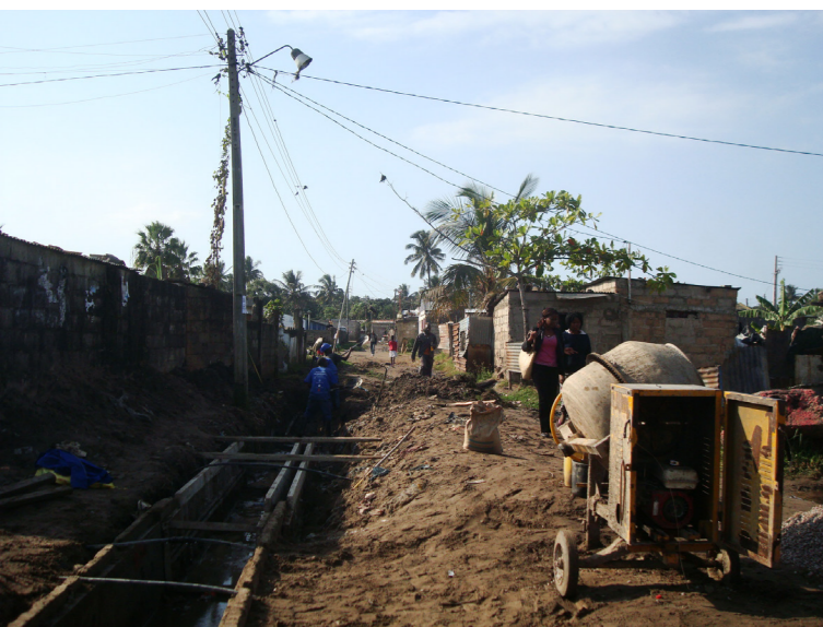
Figura 4 – Construção de valas de drenagem em Maxaquene-A. Fonte: elaboração própria, Jorge, 2010
