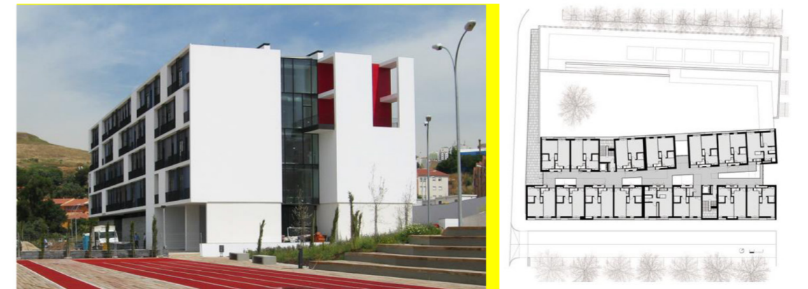
Figura 5 – Unidade Residencial Madre Maria Clara em Ourela 4 Arquitectura: CVDB arquitectos.
