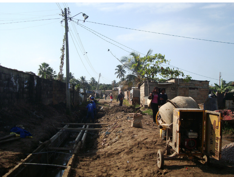
Figura 4 – Construção de valas de drenagem em Maxaquene-A. Fonte: elaboração própria, Jorge, 2010
