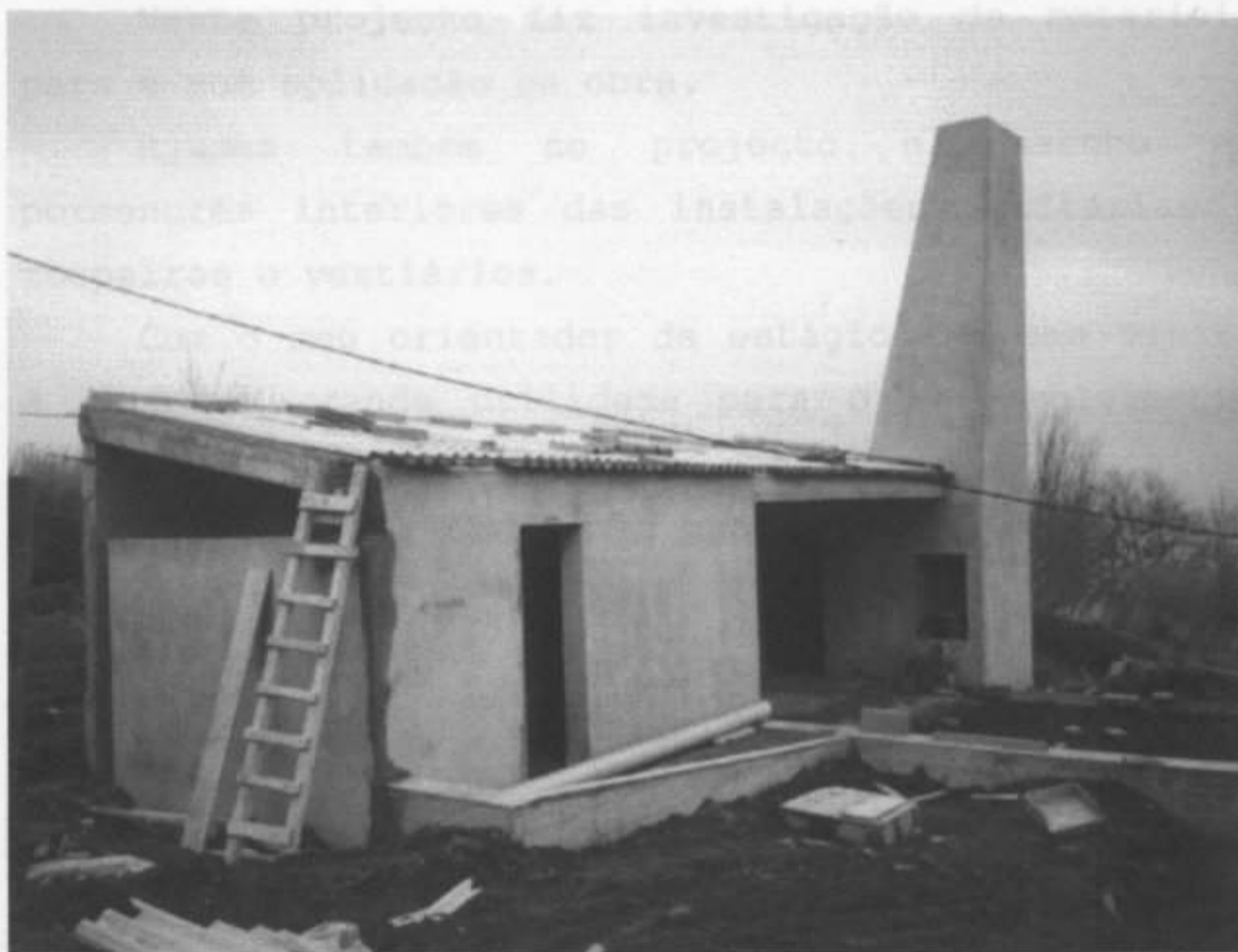
Equipamento de apoio ao uso exterior Fotografia da obra em curso.
