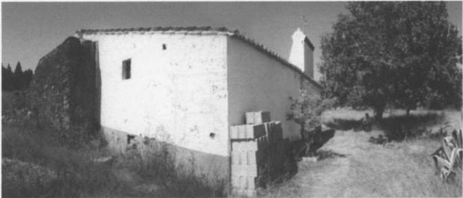
Alçado sul e sudoeste existente.
