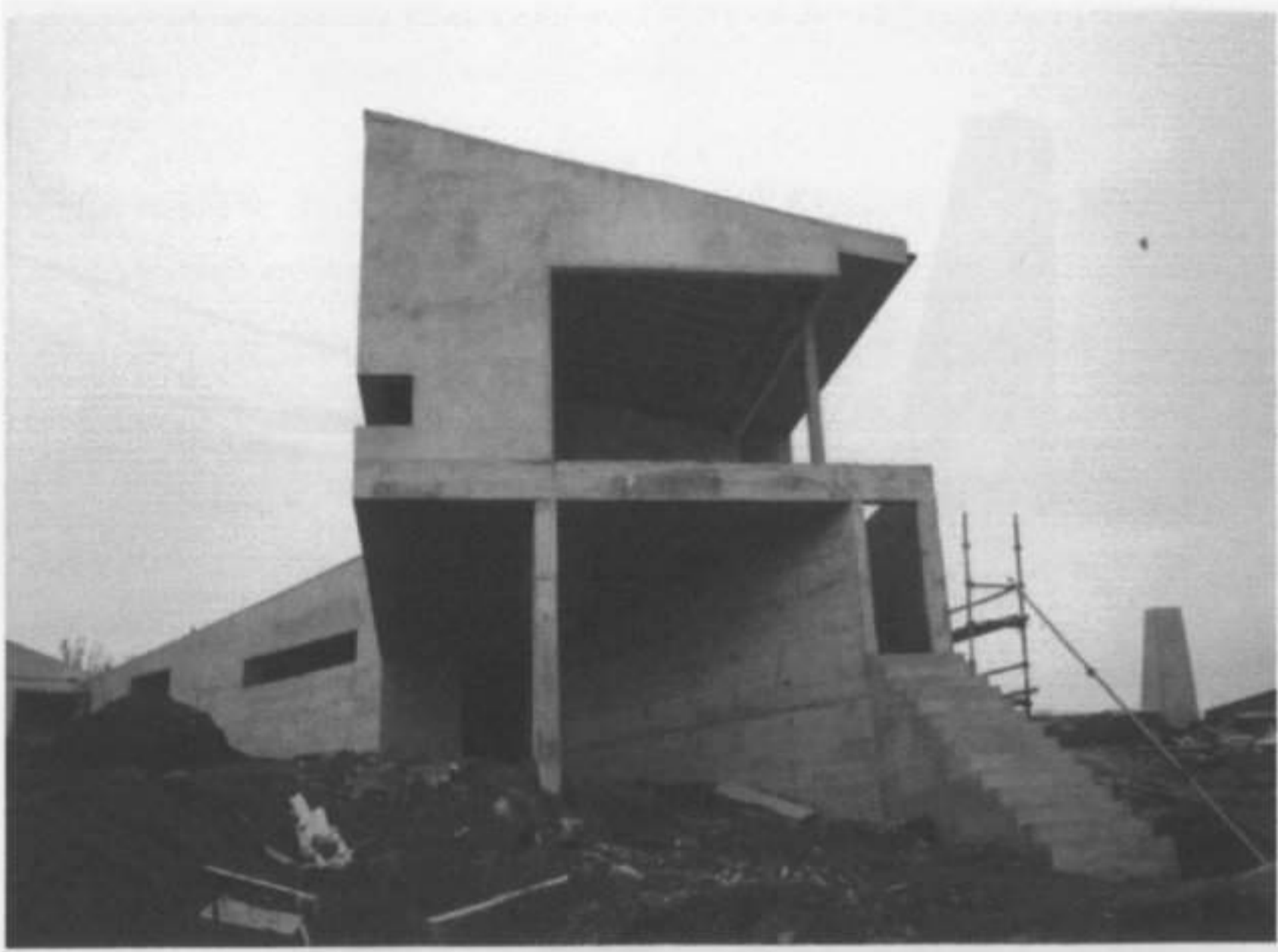
Equipamento de apoio ao uso exterior. Fotografia da obra em curso.
