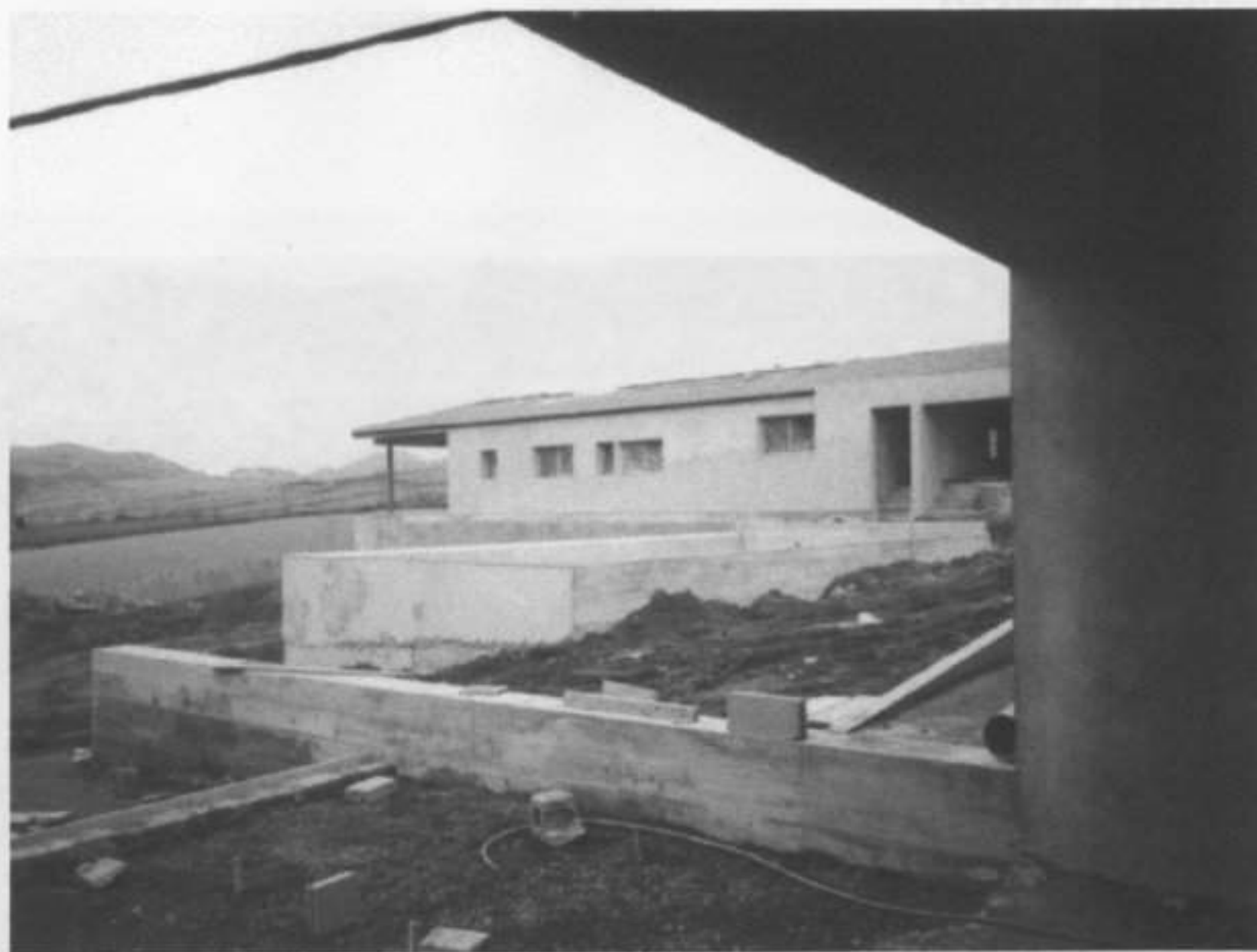
Alçado sul. Fotografia da obra em curso.
