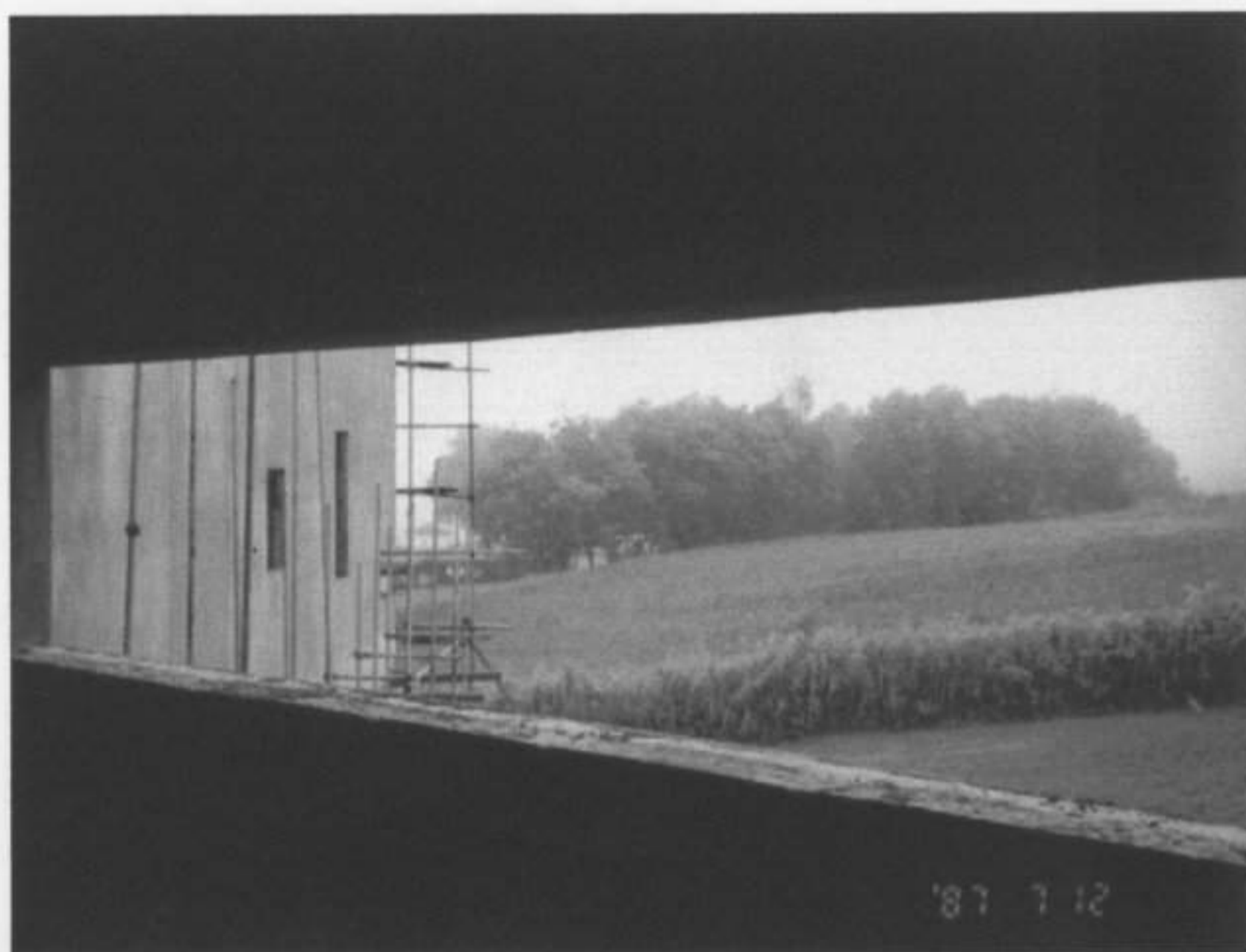
Vista do vão exterior da cozinha. Fotografia da obra em curso.
