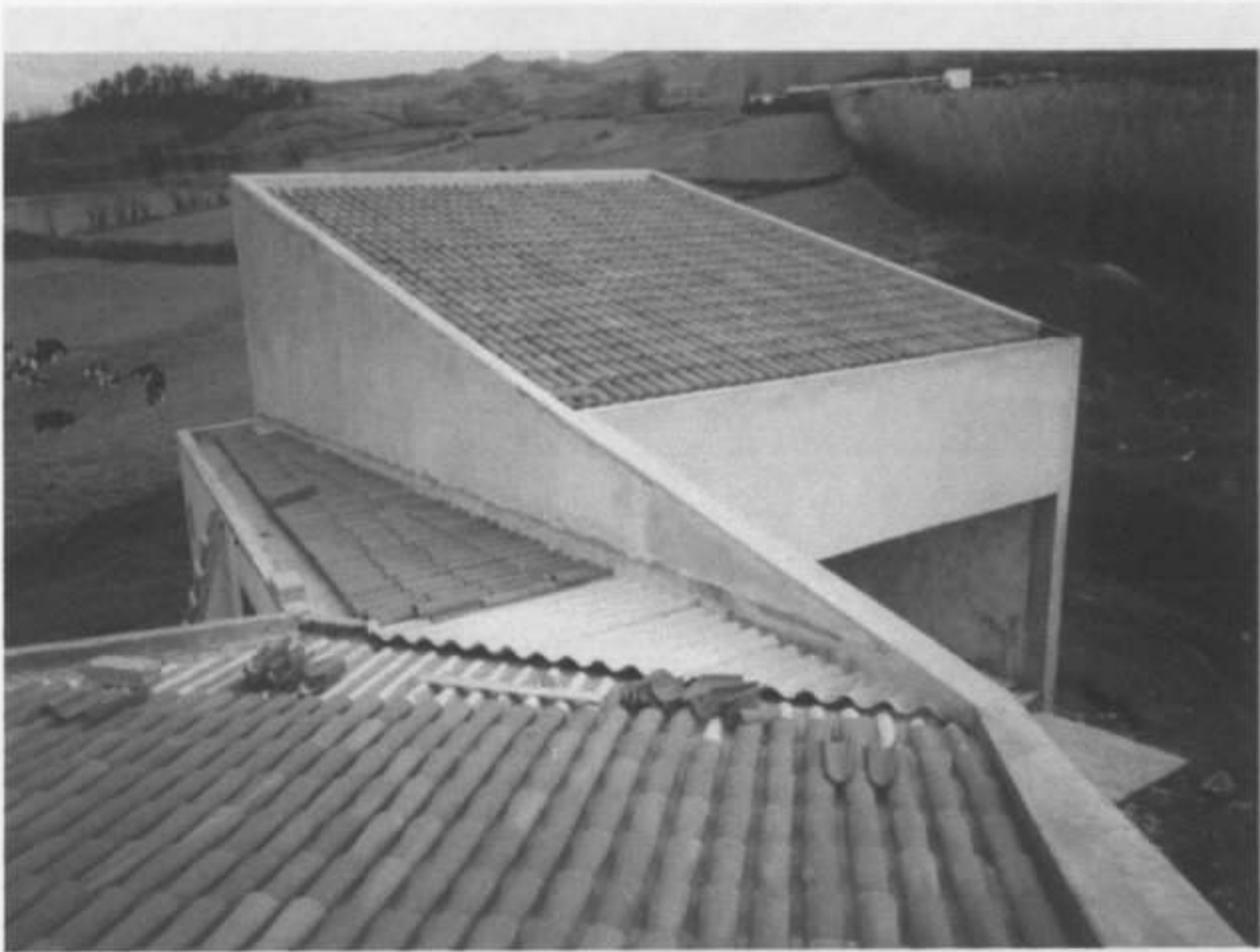
Vista da obra em curso. Fotografia da obra em curso.
