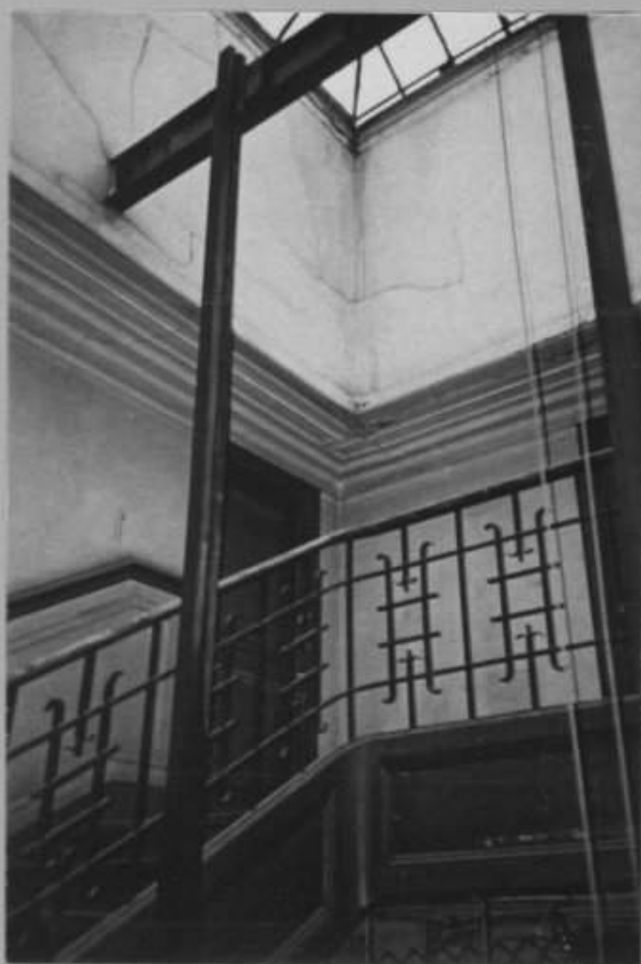
Fig. 4 - Caixa de Escadas
