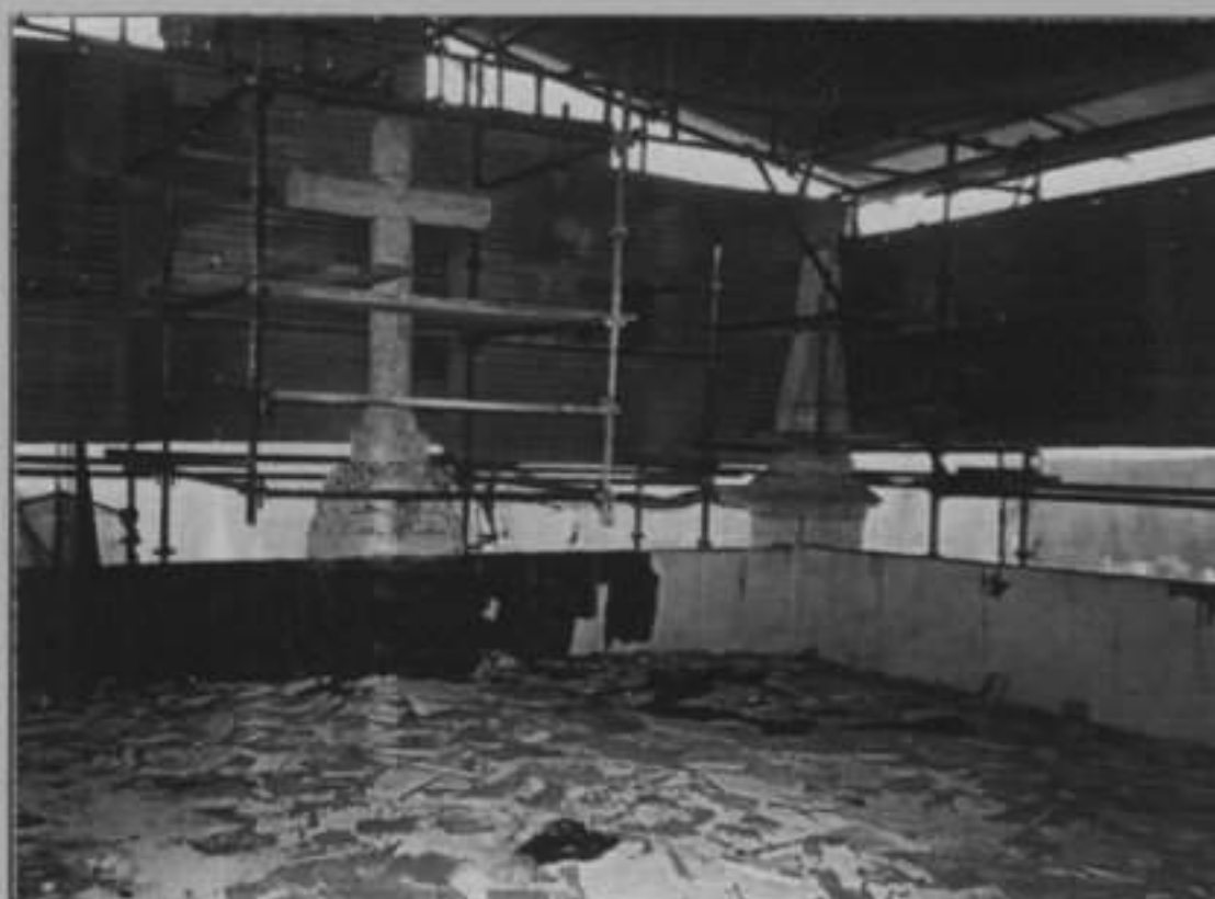
Fig. 17 - Remoção da tijoleira, da impermeabilização em tela de alumínio e camada de forma
