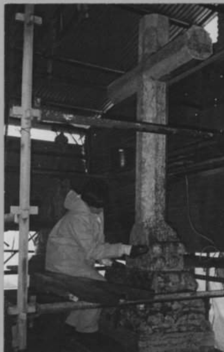
Fig. 24 – Limpeza de pedra por nebulização
