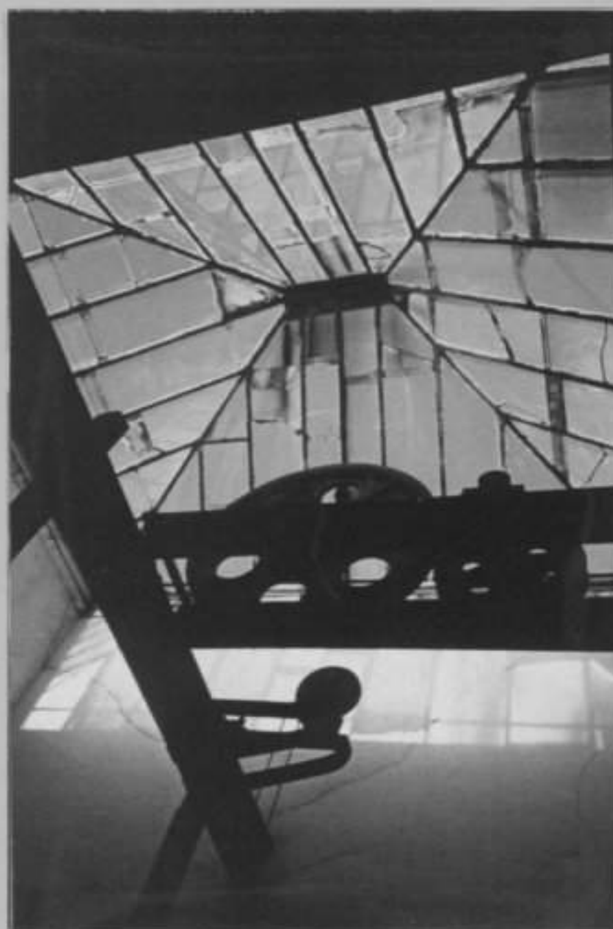
Fig. 5 - Clarabóia da caixa de escadas
