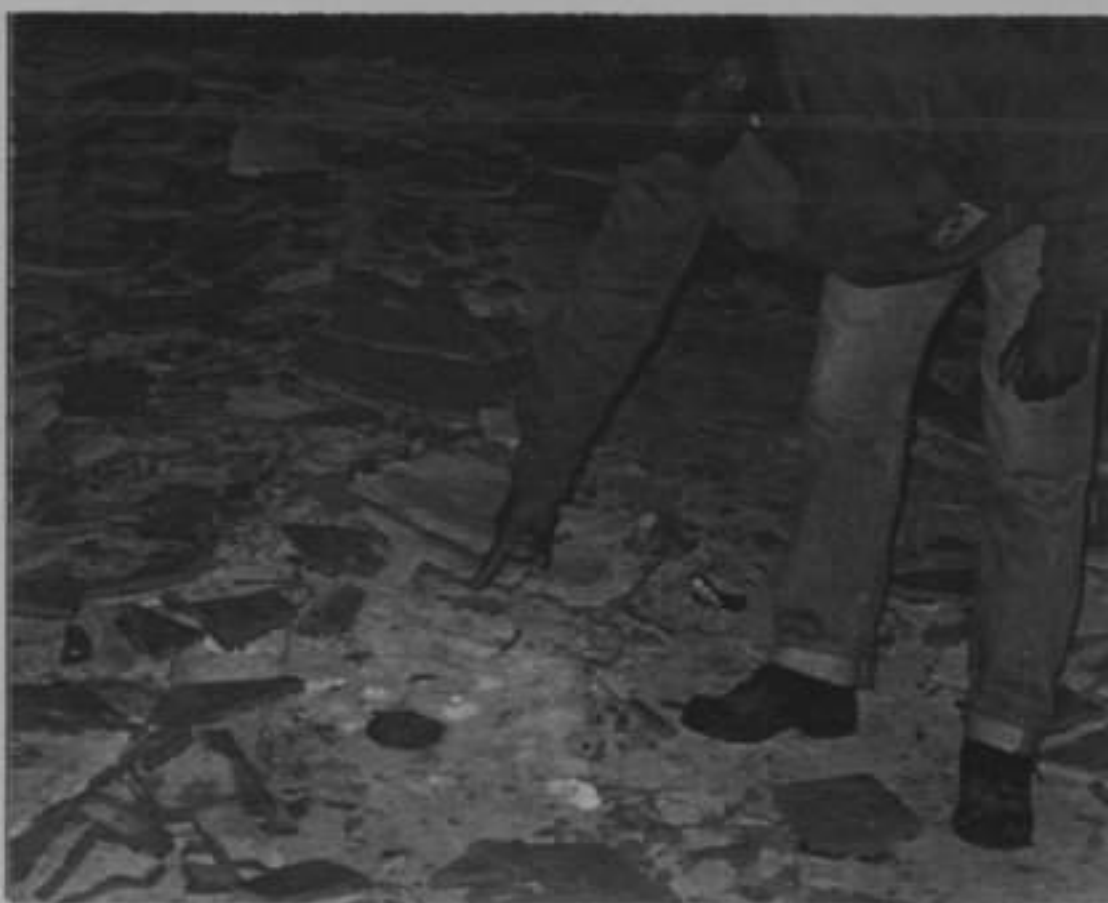
Fig. 18 - Execução de furo com equipamento de corte à rotação, dotado de coroa diamantada
