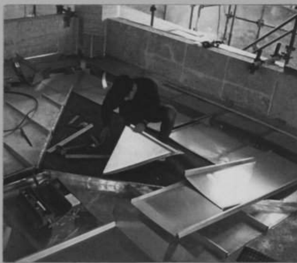
Fig. 21 – Revestimento da cobertura com chapa de zinco
