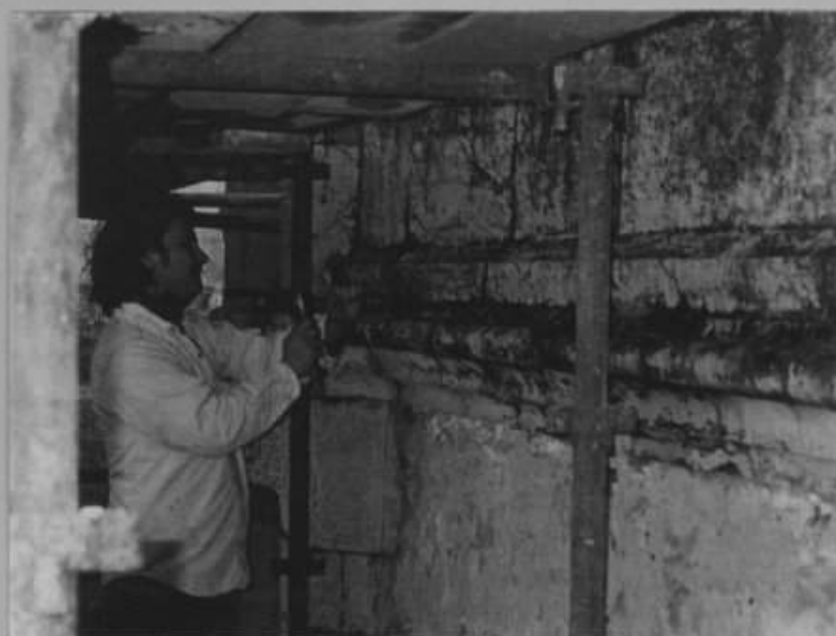
Fig. 22 – Abertura de juntas com micro-escopro e maceta
