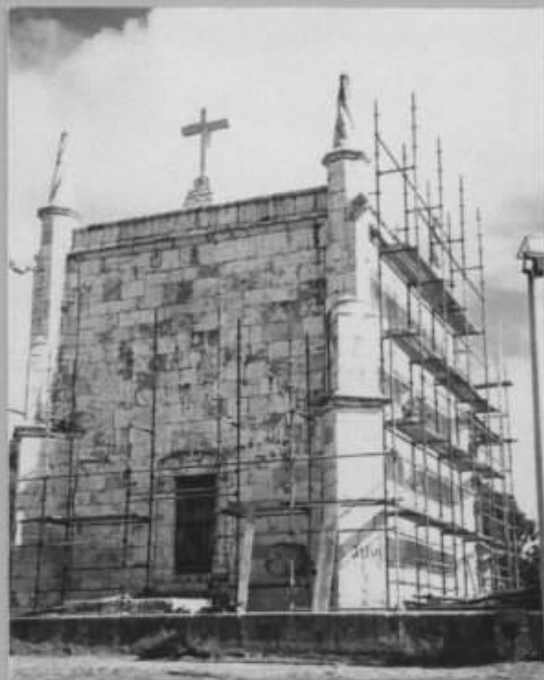
Fig. 25 – A capela antes da recuperação
