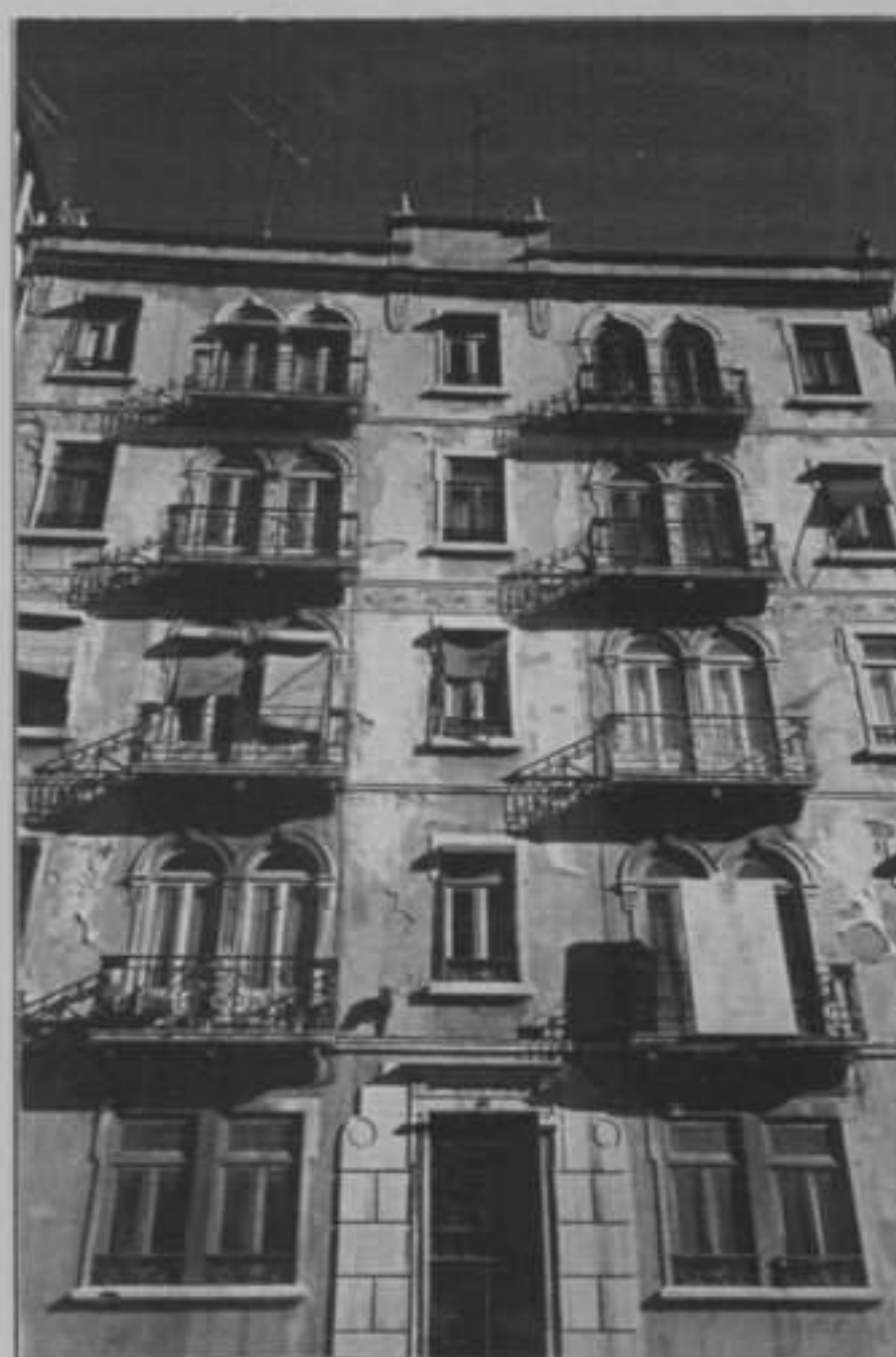
Fig.2 - Fachada Principal do n.º 68 da R. da Sociedade Farmacêutica
