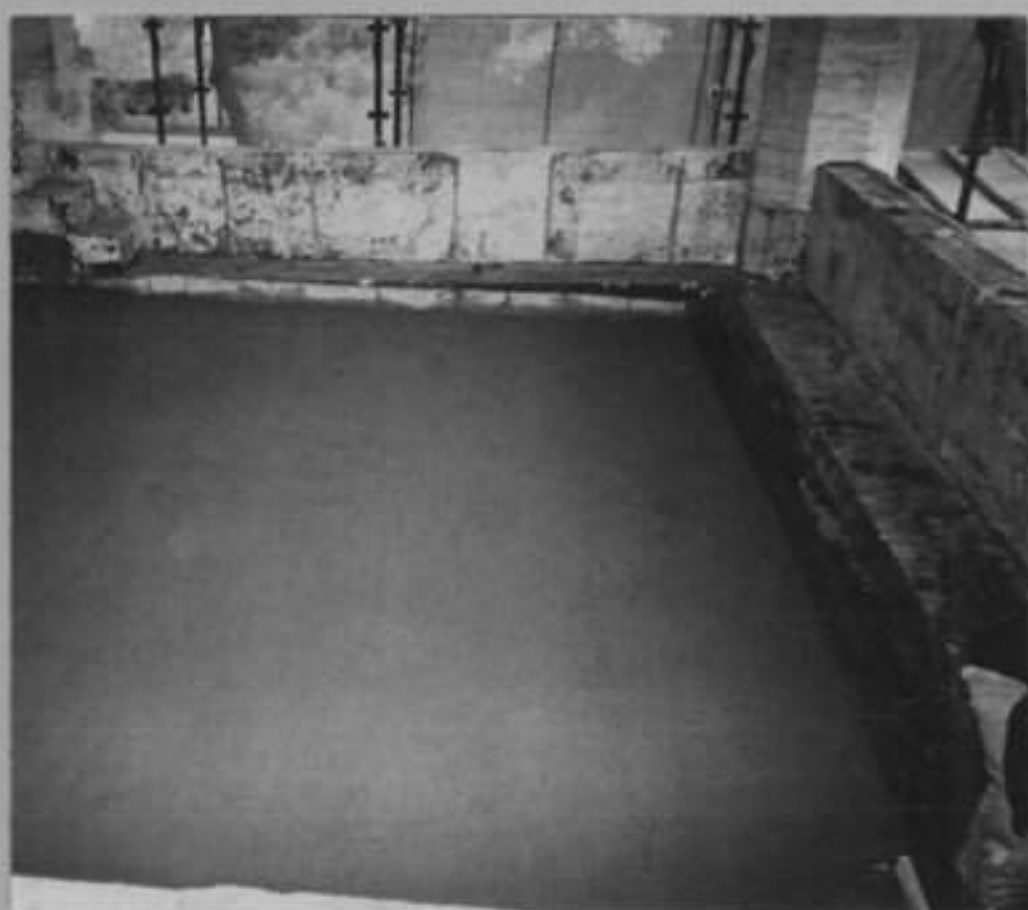
Fig. 20 – Execução de camada de forma
