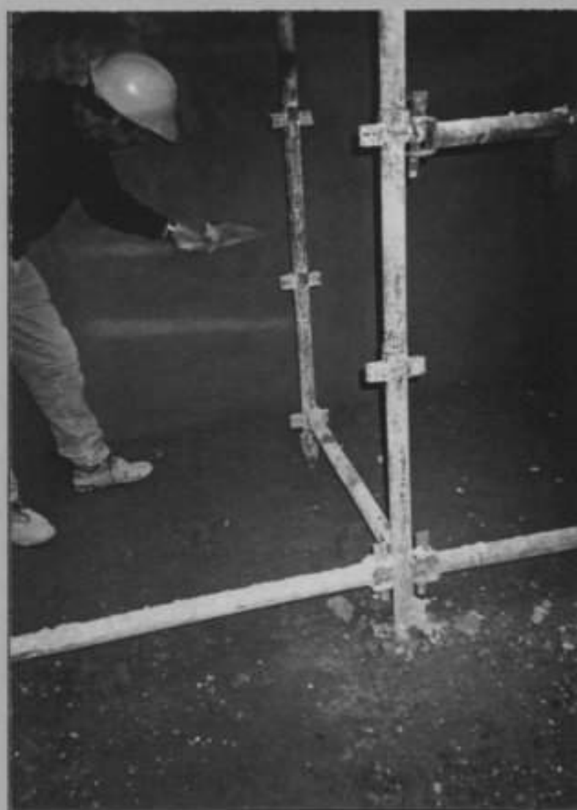
Fig. 15 – Execução de reboco afagado à colher
