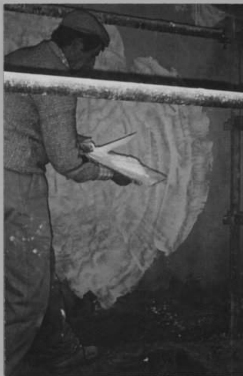
Fig. 16 – Barramento com pasta de cal
