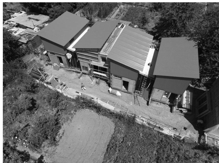
Imagem 3 - Estaleiro da escola
