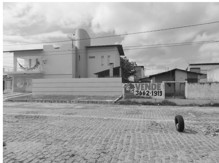
Imagem 1 - Casa reformada e casa padrão, Conjunto Soledade
