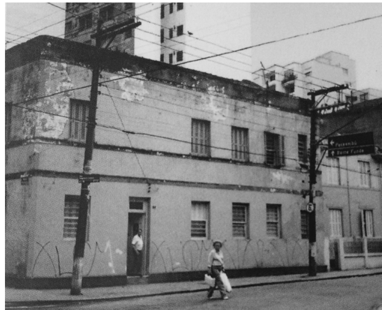
Imagem 3 - Casarão original que foi ocupado
