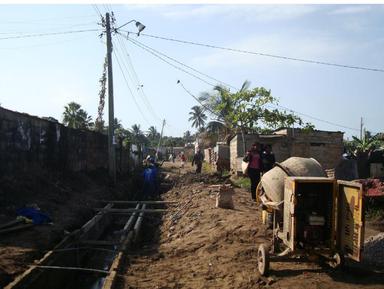
Figura 4 – Construção de valas de drenagem em Maxaquene-A.
