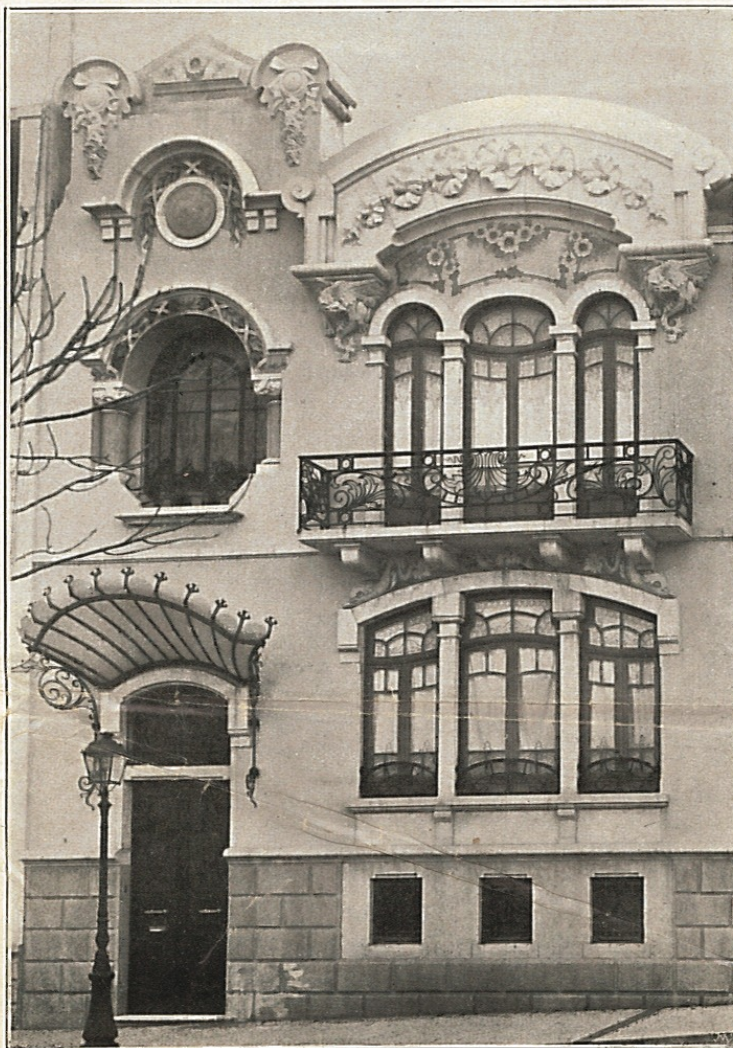
DETALHE DA FACHADA PRINCIPAL SOBRE A AVENIDA CINCO DE OUTUBRO
