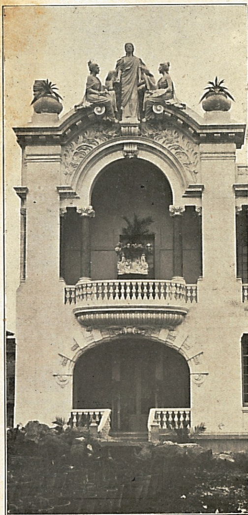
Detalhe da fachada sobre o Parque Eduardo VII
