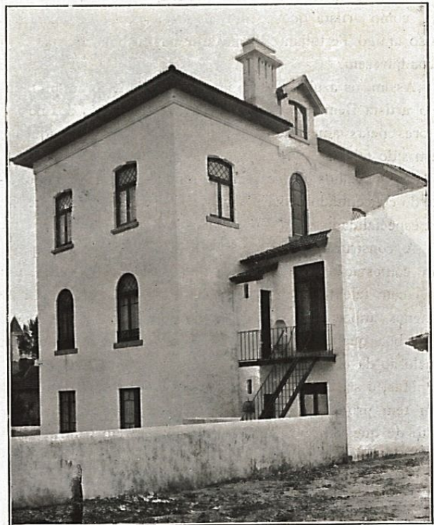
Prespectiva da fachada posterior e lateral norte
