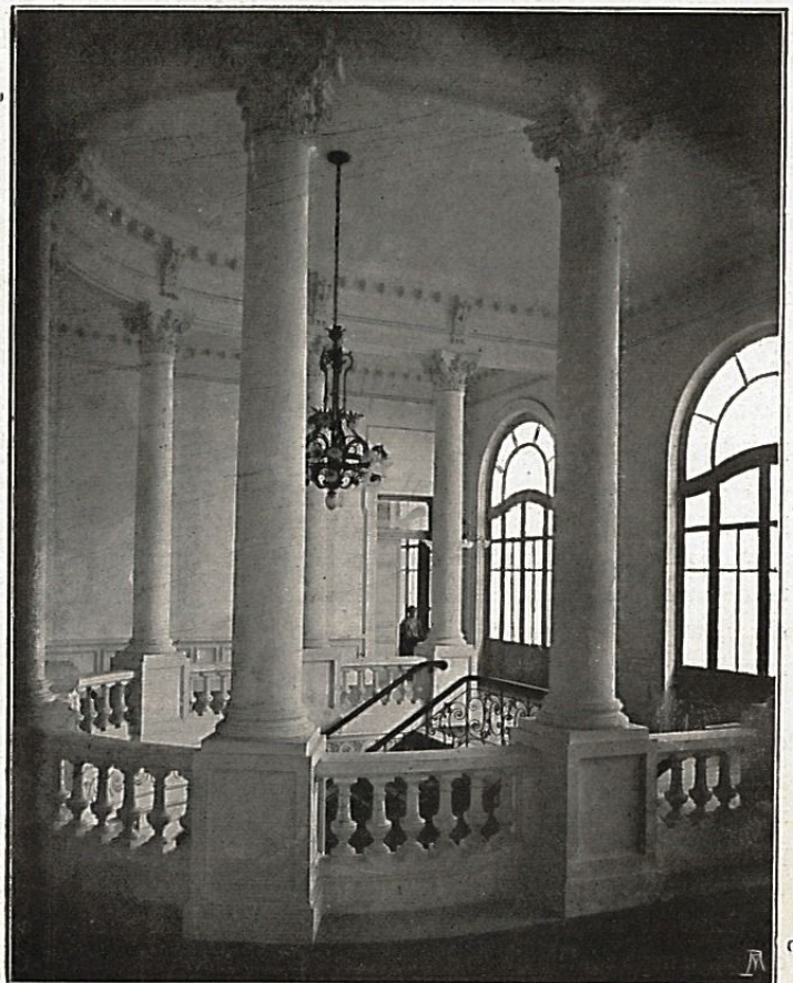
Escada nobre e vestibulo de honra
