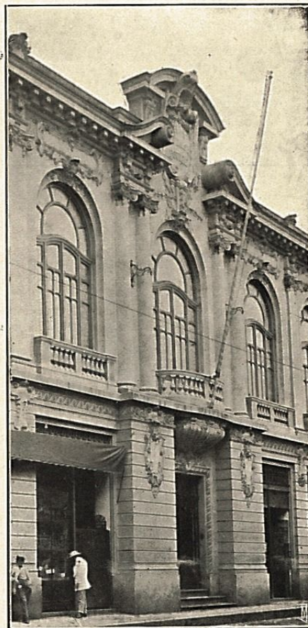
Detalhe da fachada sobre a rua do Hospicio Entrada principal
