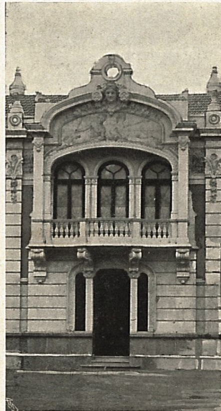
Detalhe da fachada principal — Corpo central
