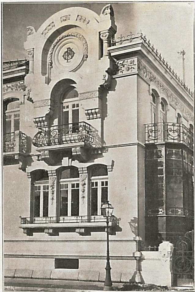
Detalhe da fachada sobre a Avenida da Praia da Victoria
