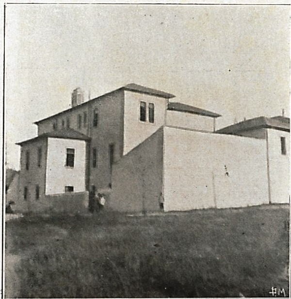
Detalhe de uma fachada lateral
