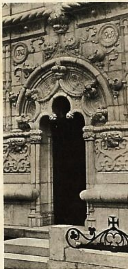
Detalhe da fachada principal
