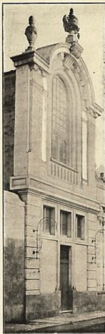
Detalhe da fachada — Co po do lado sul
