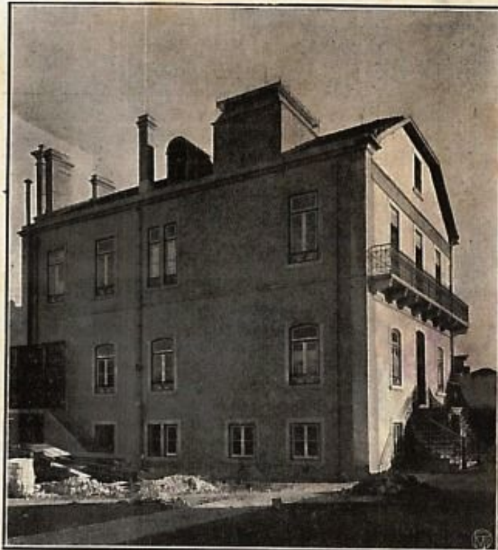
Fachada posterior e lateral
