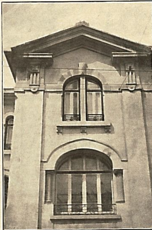
Um detalhe da fachada principal
