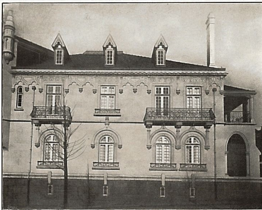
FACHADA SOBRE A RUA BARROS GOMES
