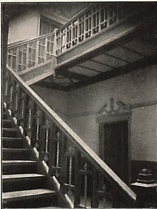
Hall e escada
