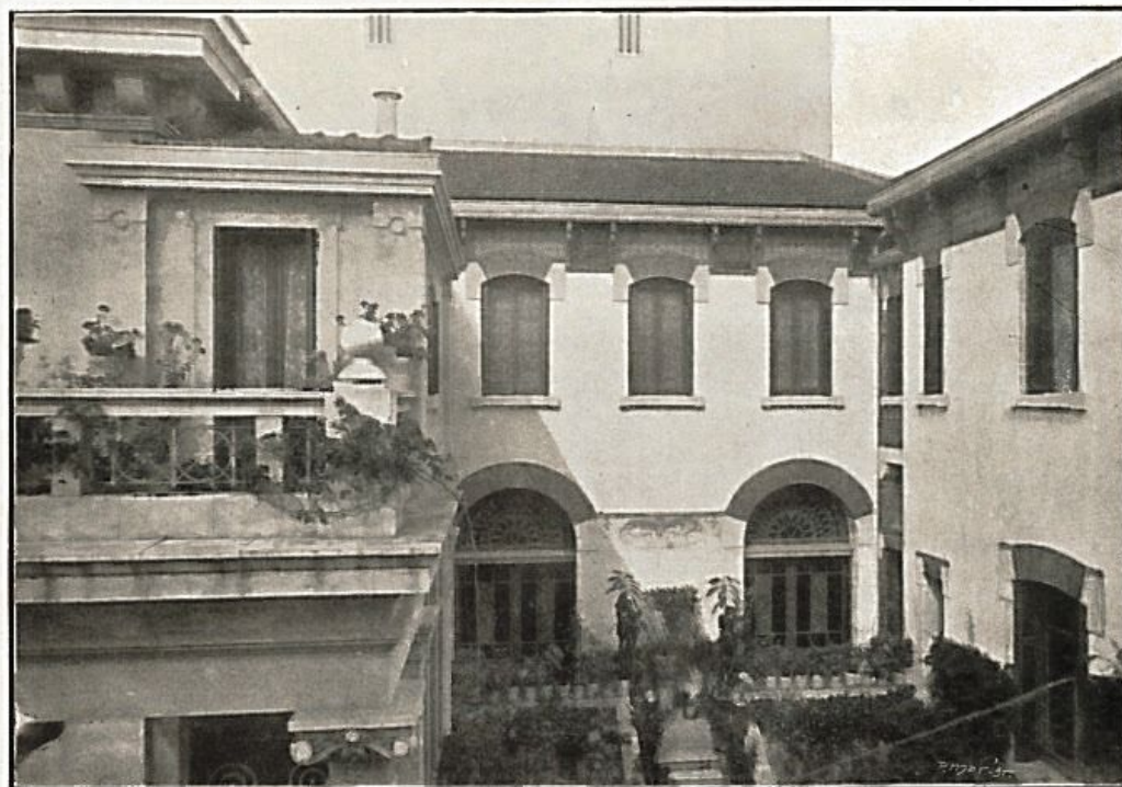
UM TRECHO DA FACHADA LATERAL SUL
