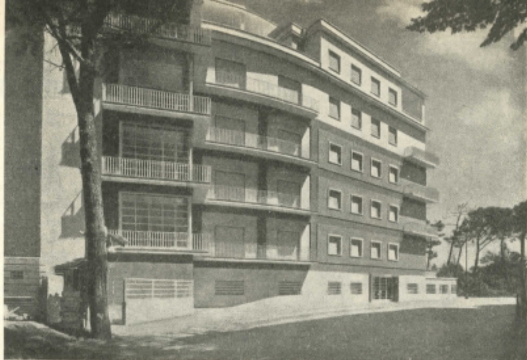
Aspecto duma fachada
