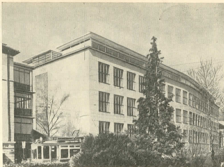
Fig. 1 — Vista geral do edifício, com o seu novo pavimento
