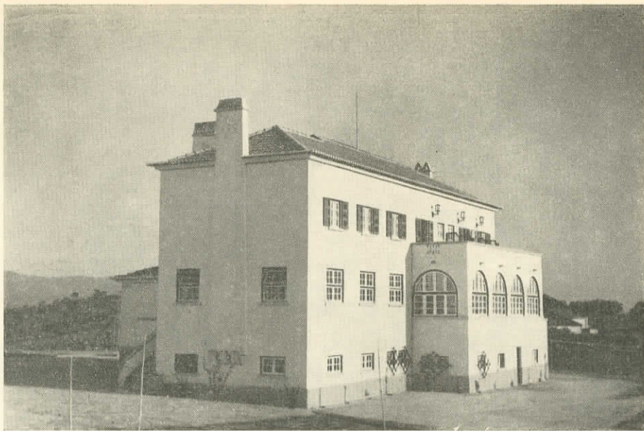
Edifício Principal Aspecto Noroeste
