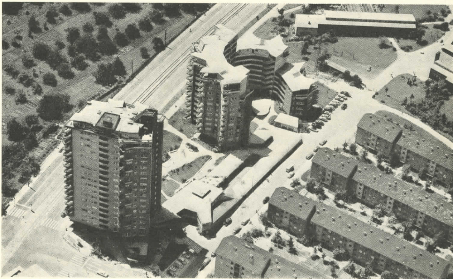
«Romeu» (à esquerda) e «Julietta» à direita. Entre os dois edifícios o conjunto de garagens com restaurante e café no piso superior. No último andar dos edifícios previram-se «ateliers».
