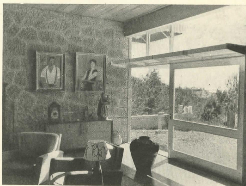
enchimentos a «tijomel». Conjugou-se uma estrutura de betão (pilar e viga) com elementos de pedra (paredes da sala e do «atelier»), ficando estes exteriormente com o corte natural da pedra e interiormente a ponteiro.
