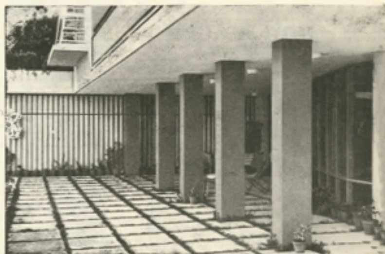
Zona exterior que é o prolongamento da sala do 1.º piso
