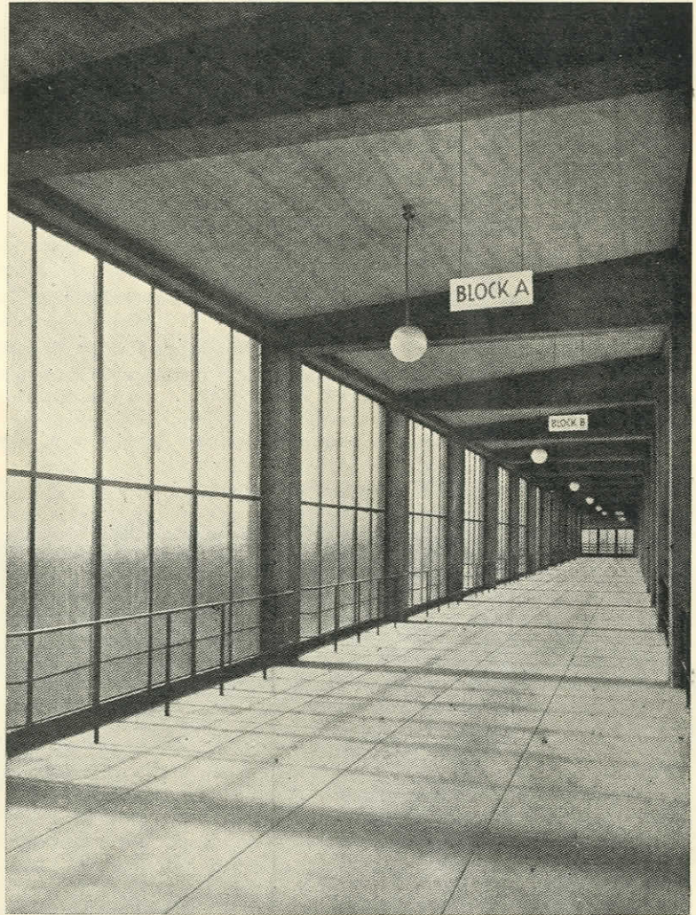
A GALERIA DE ACESSO ÀS BANCADAS
