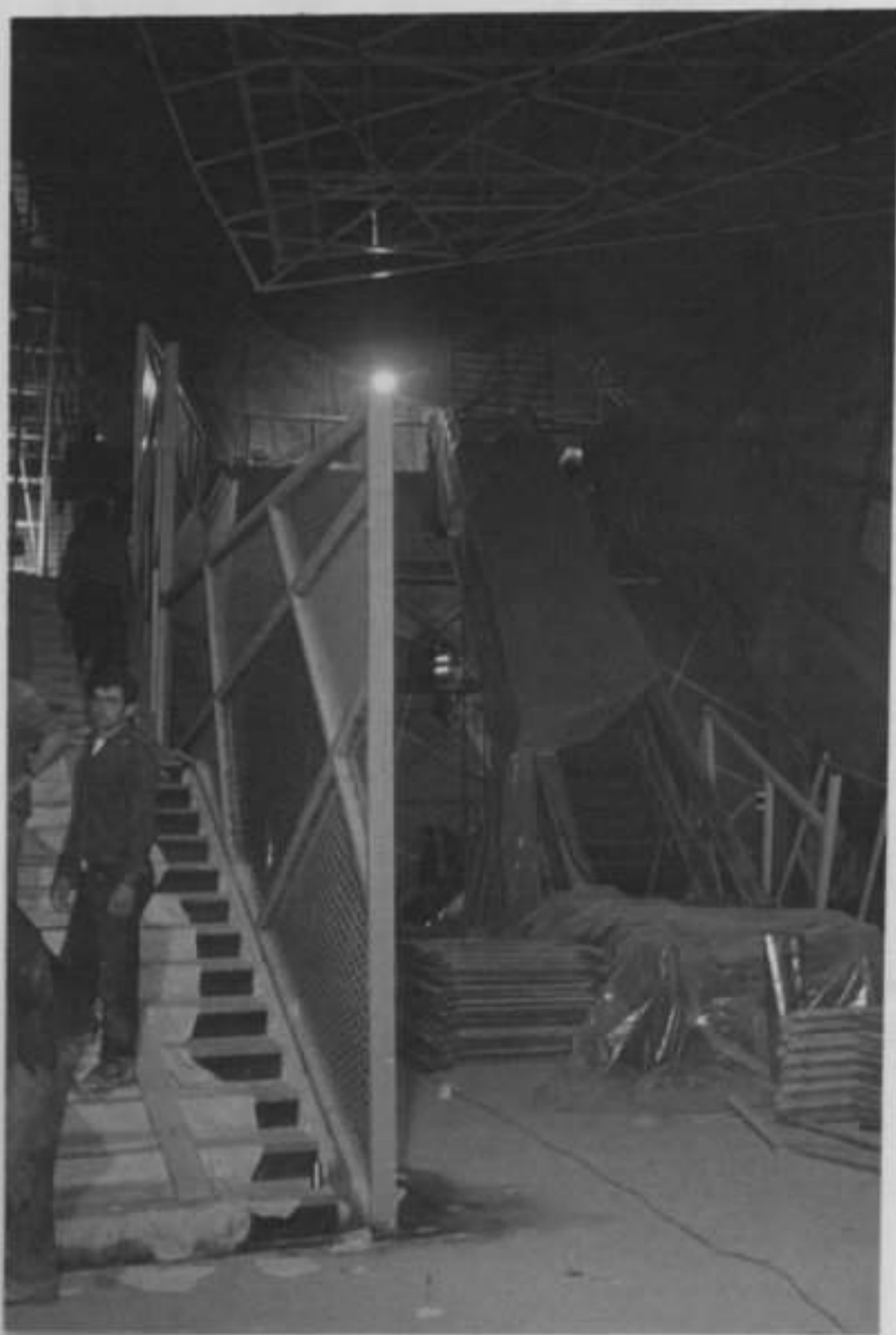
Fotografias tiradas durante a visita à obra
