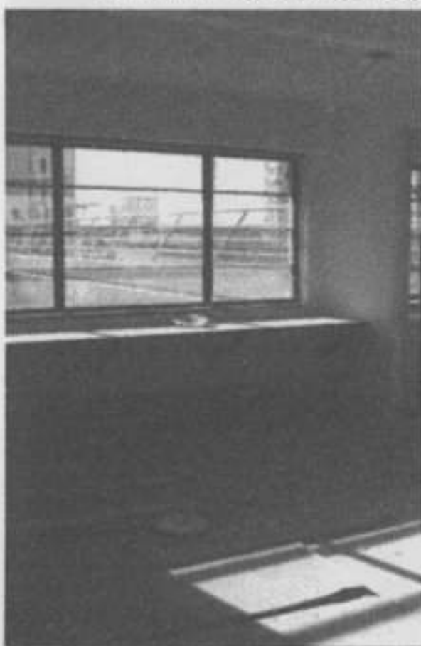
Foto 29 – bancadas em mármore azul cascais, com poleias metálicas, cota 99.90
