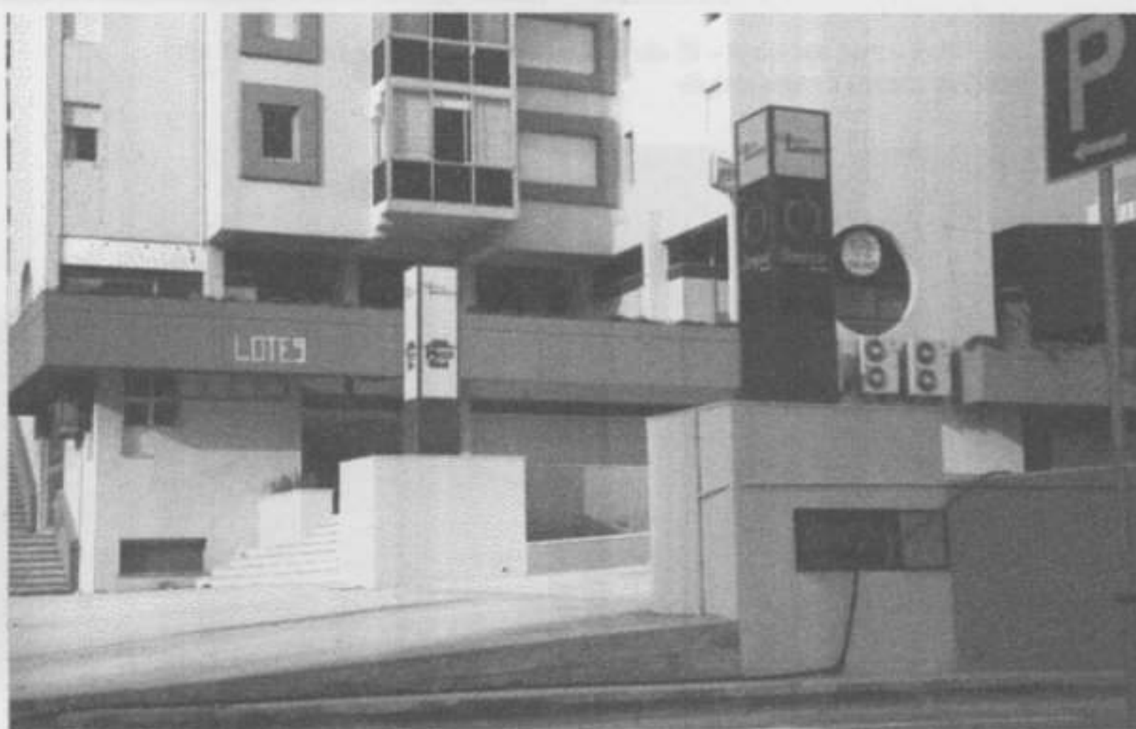
Foto 37 – Galeria Comercial, rampa de acesso ladeada por dois totens com iluminação interior
