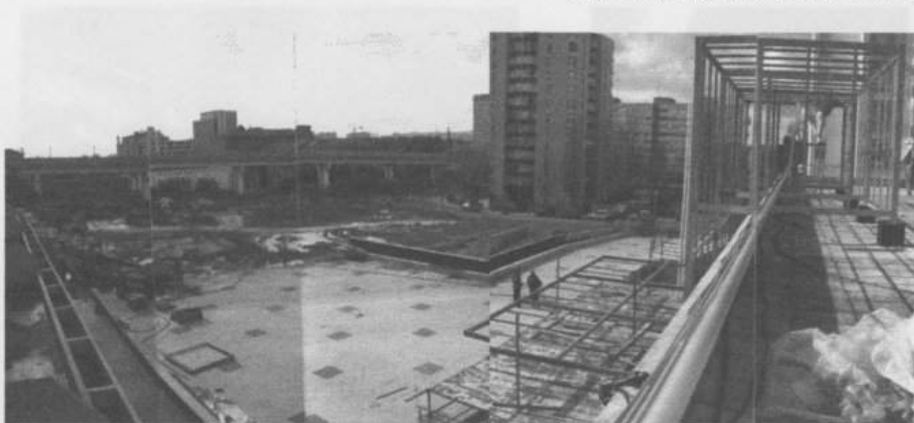
Foto 39 – Andaimos para a montagem da estrutura da pala sobre a entrada da Galeria Comercial
