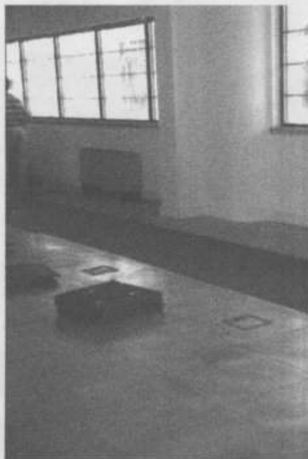
Foto 33 – Colocação de placas de alcatifa Tecssom sobre o pavimento falso
