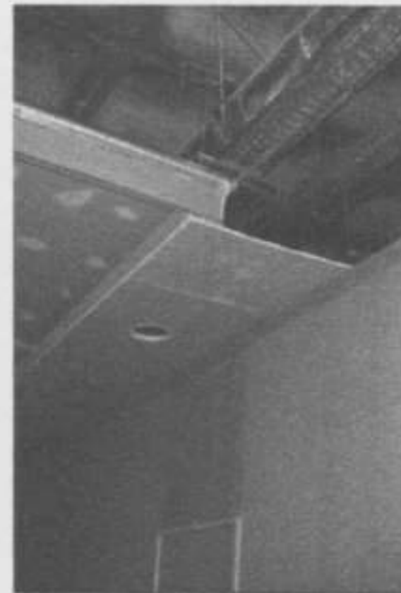
Foto 44 – Tecto falso e sanca de iluminação
