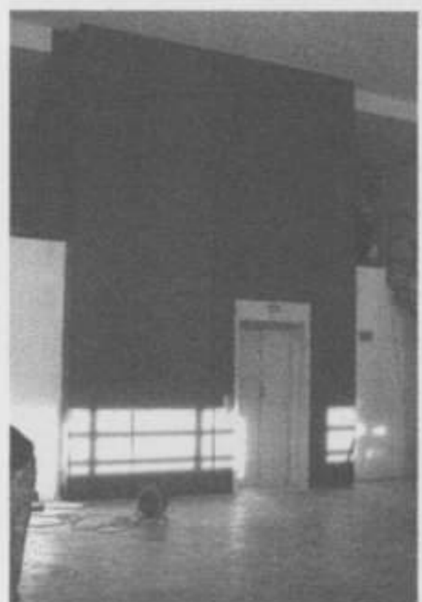
Foto 25 – caixa de elevador revestida a placas de Viroc pintadas, cota 97.20
