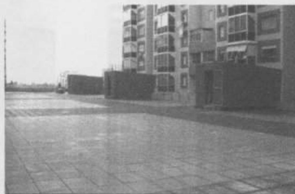
Foto 7 – Cobertura cota 100.65, estruturas sobre aparelhos de AVAC
