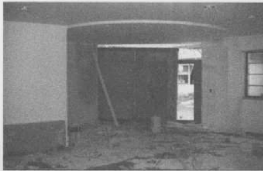
Foto 14 - Entrada escritórios interior, cota 99.90
