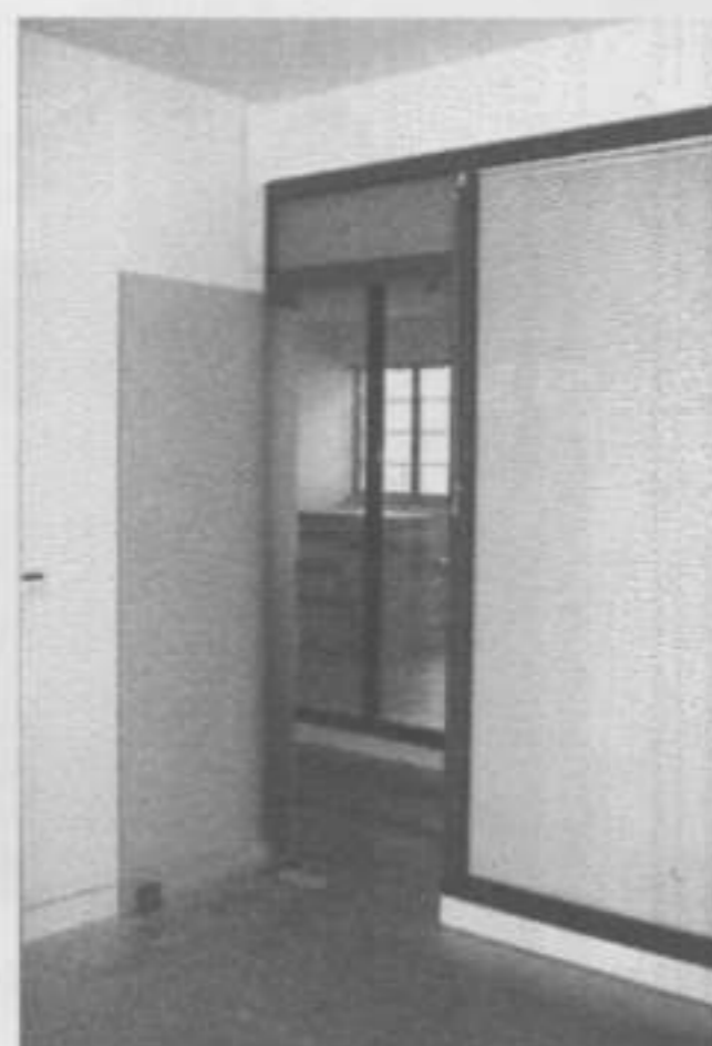
Foto 34 – divisórias em vidro com estore metálico interior, e porta em vidro fosco
