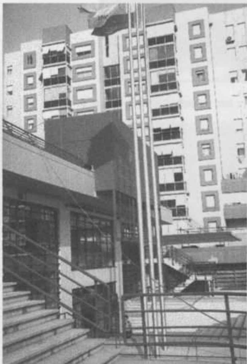
Foto 38 – Entrada Galeria Comercial
