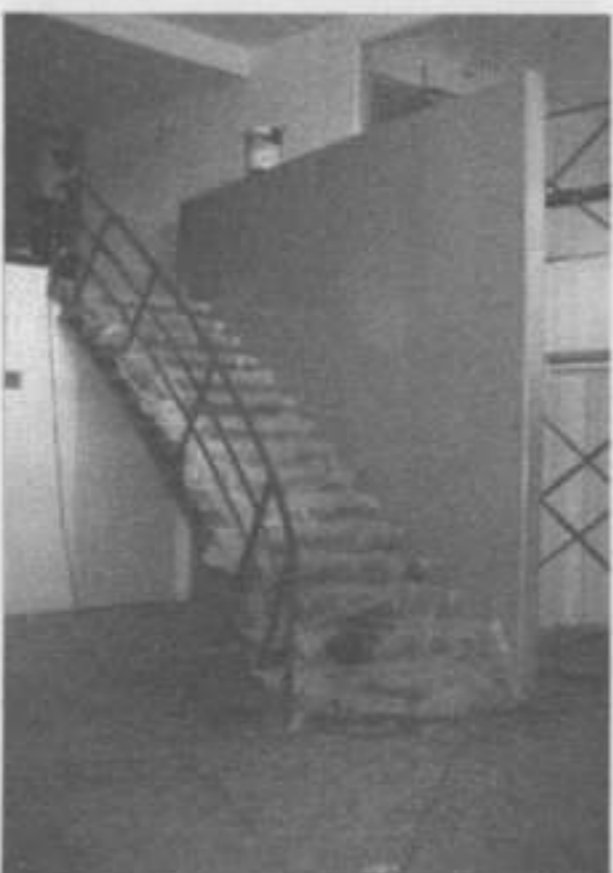
Foto 24 – Escada com estrutura metálica, cobertor revestido a carvalho, cota 97.20
