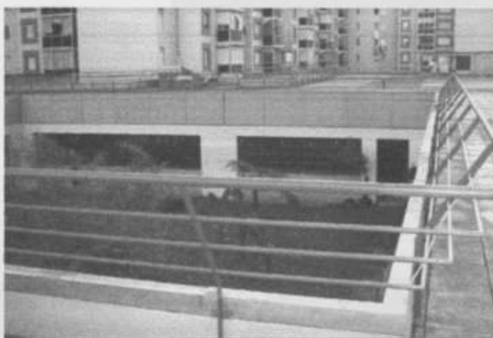
Foto 6 – Cobertura cota 100.65, vista para jardim interior à cota 97.20
