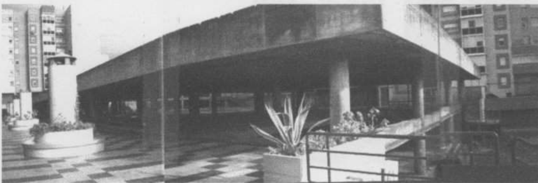
Foto 4 - Estrutura inicial, cota 94.50
