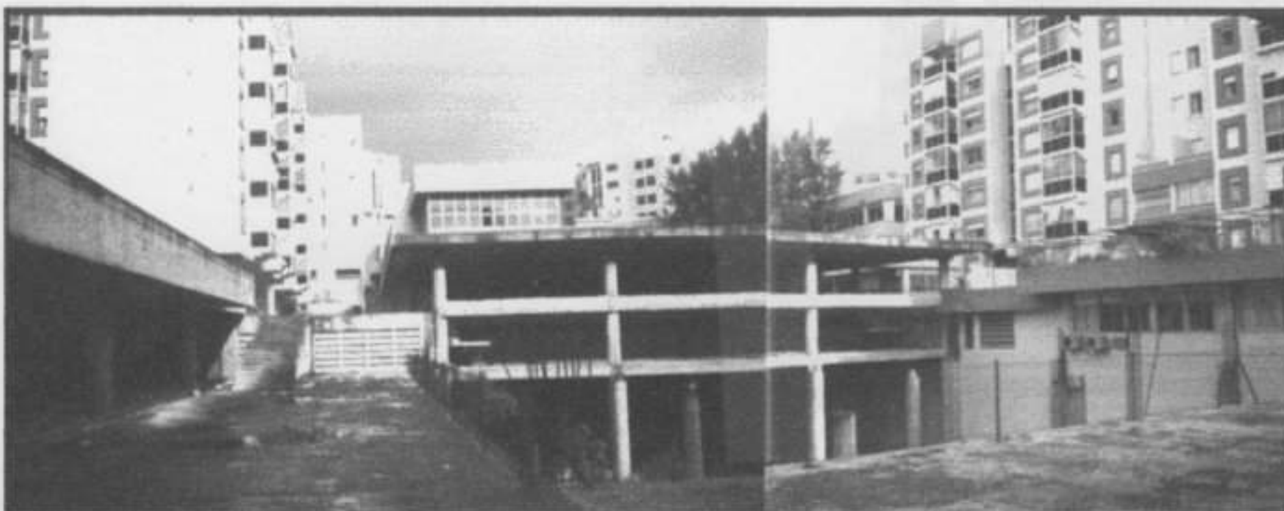
Foto 3 - Estrutura inicial, cotas 97.20 e 99.90
