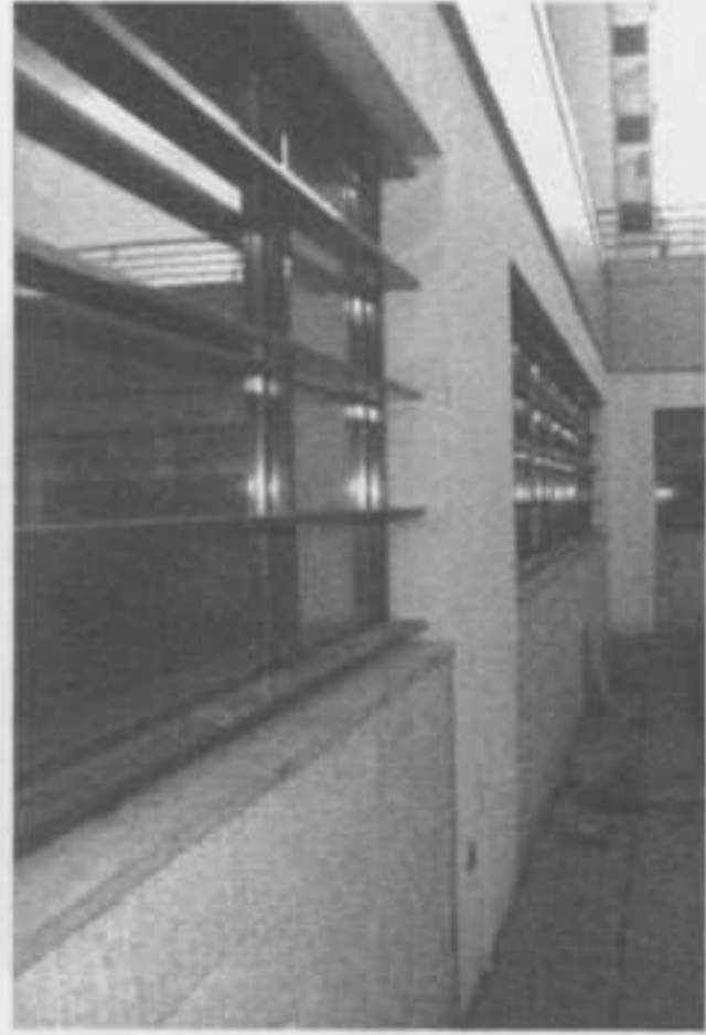
Foto 10 – Vãos no jardim interior, lâminas horizontais para ensombramento em alumínio
