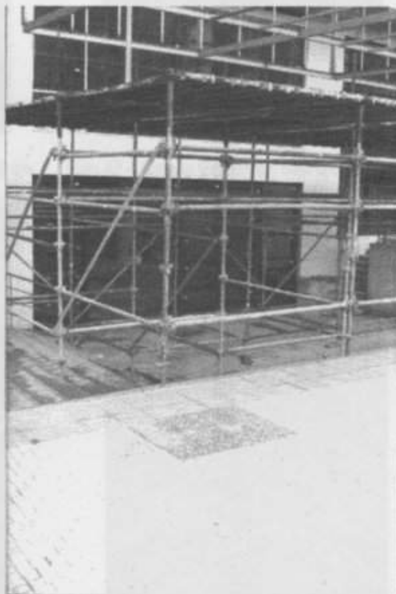
Foto 39 – Andaimos para a montagem da estrutura da pala sobre a entrada da Galeria Comercial
