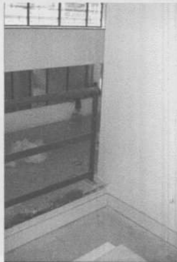
Foto 28 – pormenor do corrimão, cota 99.90
