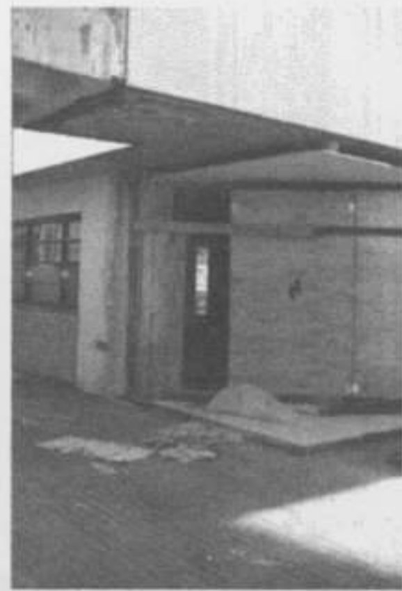
Foto 15 - Entrada escritórios exterior, cota 99.90
