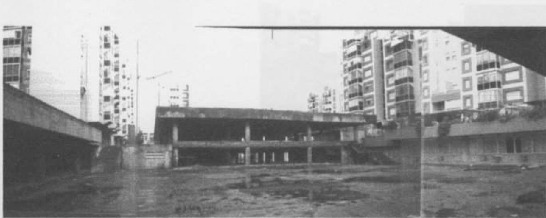
Foto 1 - Estrutura inicial, cotas 94.50 e 97.20
