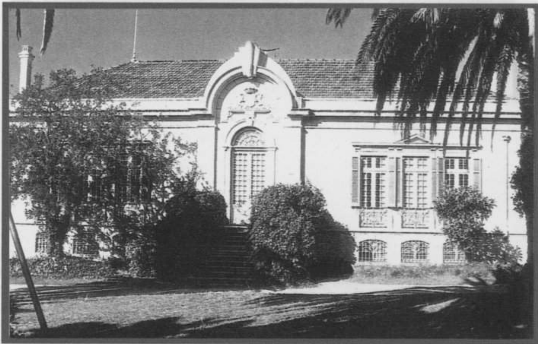
Fotografia n.º 3 – Fachada a nascente, com a entrada principal do palacete. É possível observar, como elemento decorativo e ao mesmo tempo indicativo do título que tinha o proprietário, o brasão de armas no todo das portadas.
