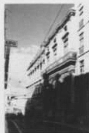
Fachada principal do Palácio Marim Olhão. Calçada do Combro
