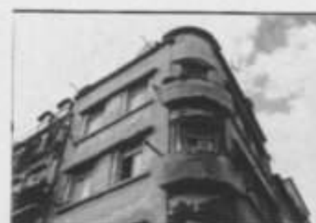
Introdução do betão armado. Travessa dos Fiéis de Deus.
