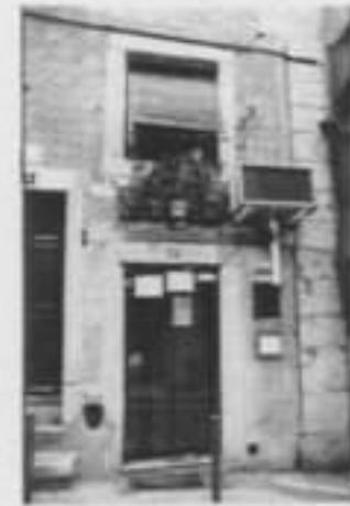
Elemento dissonante: caixa de ar condicionado
