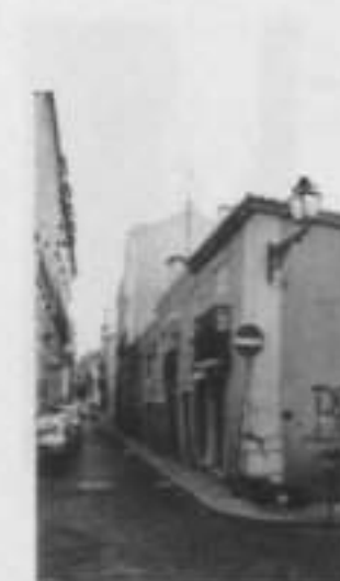
Edifício com problemas na estrutura
