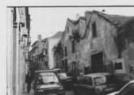
Exemplos de edifícios com sinais de avançado estado de degradação
