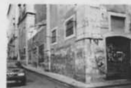
Sinais de marginalidade. Muitos toxicodependentes refugiam-se nos edifícios abandonados, para se drogarem.
