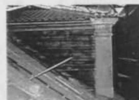
Pormenores de intervenção na Travessa da Boa Hora
