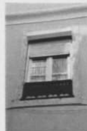
Janela de peitoril com guarda em ferro forjado
