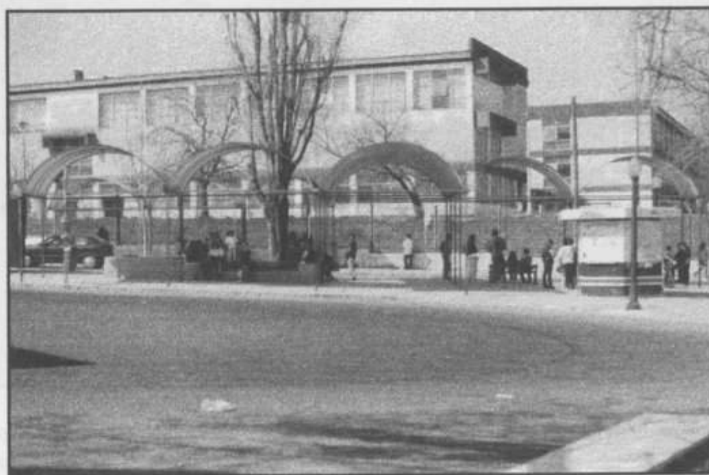
No largo do terminal do autocarro 42, junto a uma escola secundária, o abrigo existente necessita ser substituído por um novo, pois está em estado deficiente. Propõem-se algo com outra leitura arquitectónica.
