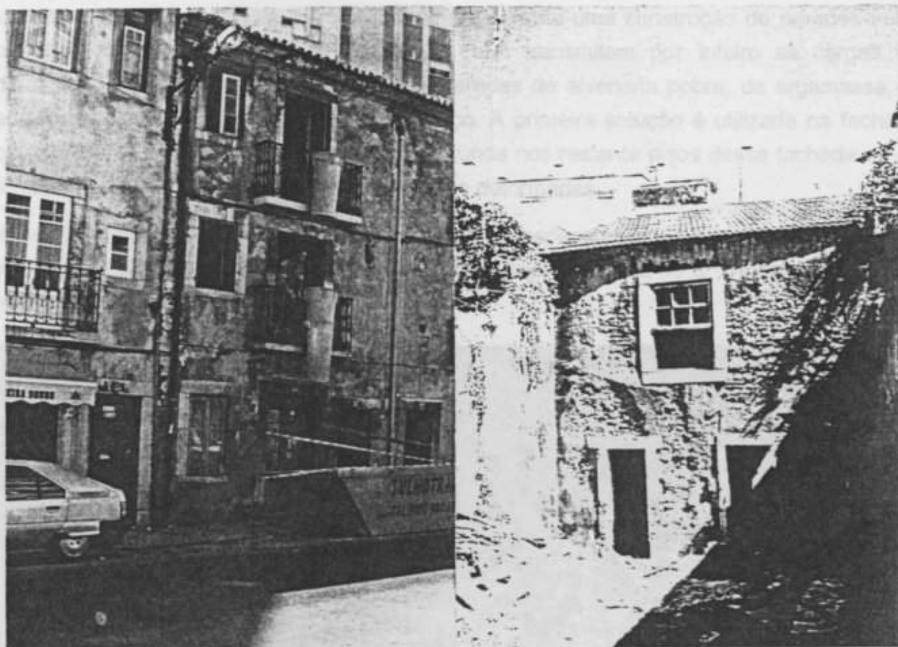
Figs. 6 e 7 – Alçados principal (a manter) e posterior (já demolido)
