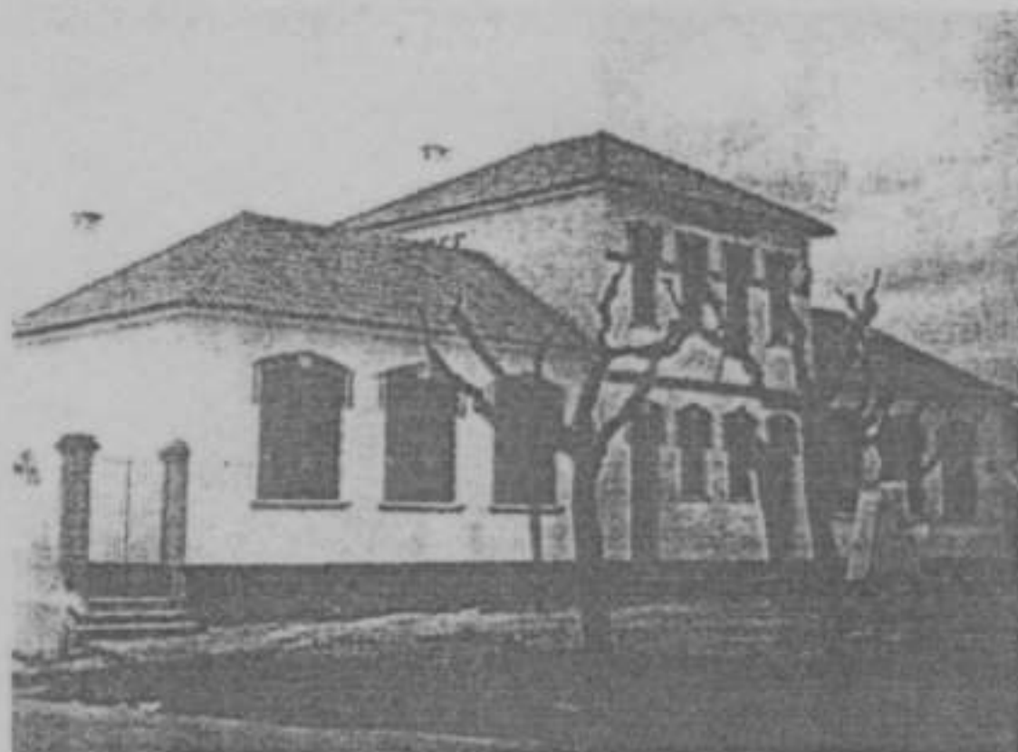
Edifício Adões Bermudes de Gáfete - Crato, recuperado em 1962 pela Direcção dos Edifícios Nacional do Sul. (Arquivo DGCE).
