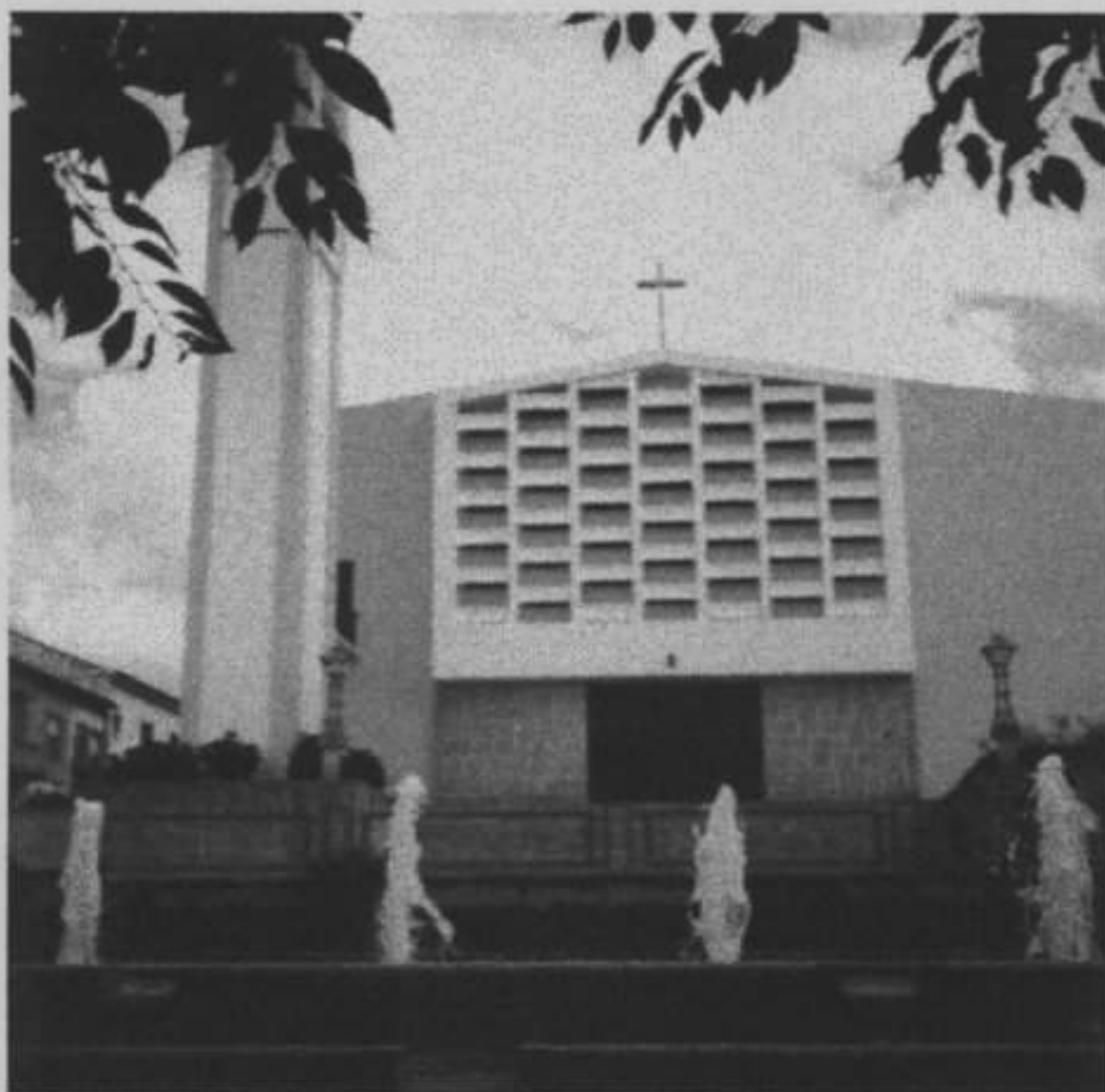
"A meio caminho da Alameda da Igreja ..."
