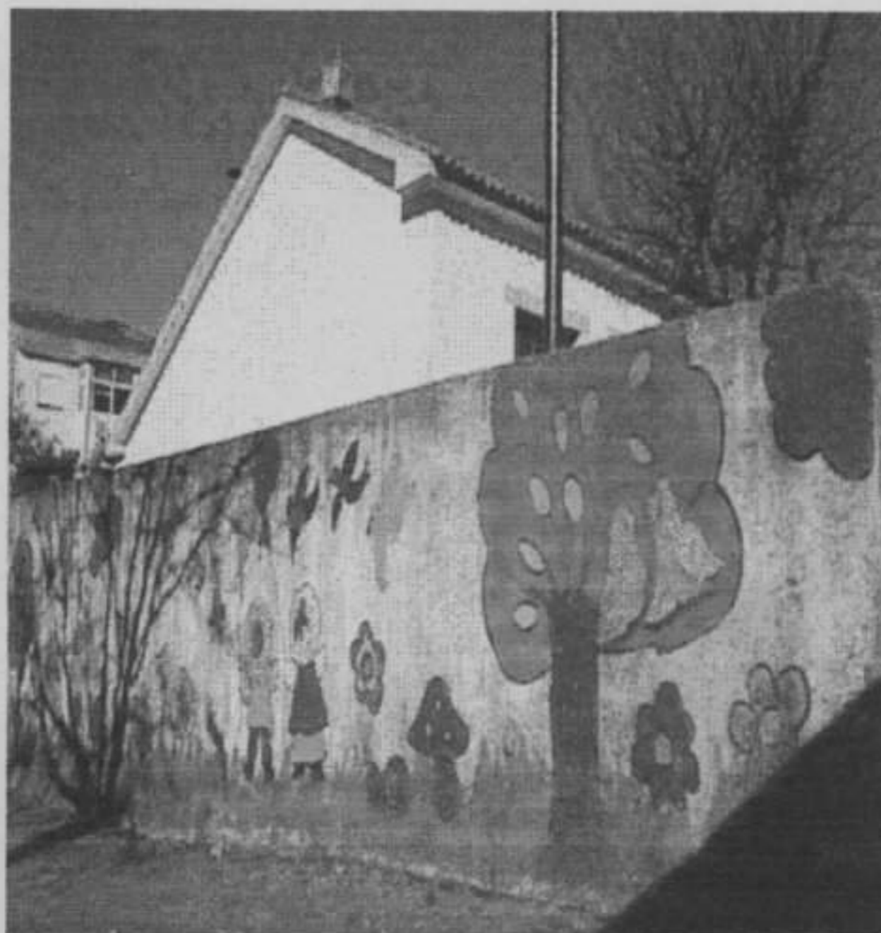
Fotografia do Muro (que separa os edifícios):
