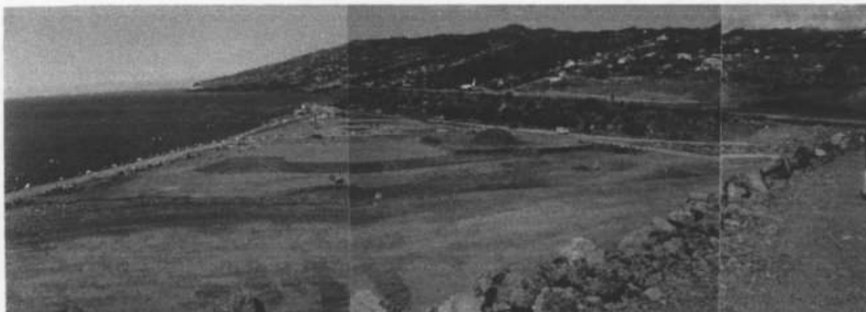
Aeroporto do Funchal - Vista sobre a zona de ampliação destinada aos edifícios de apoio (março 98)
