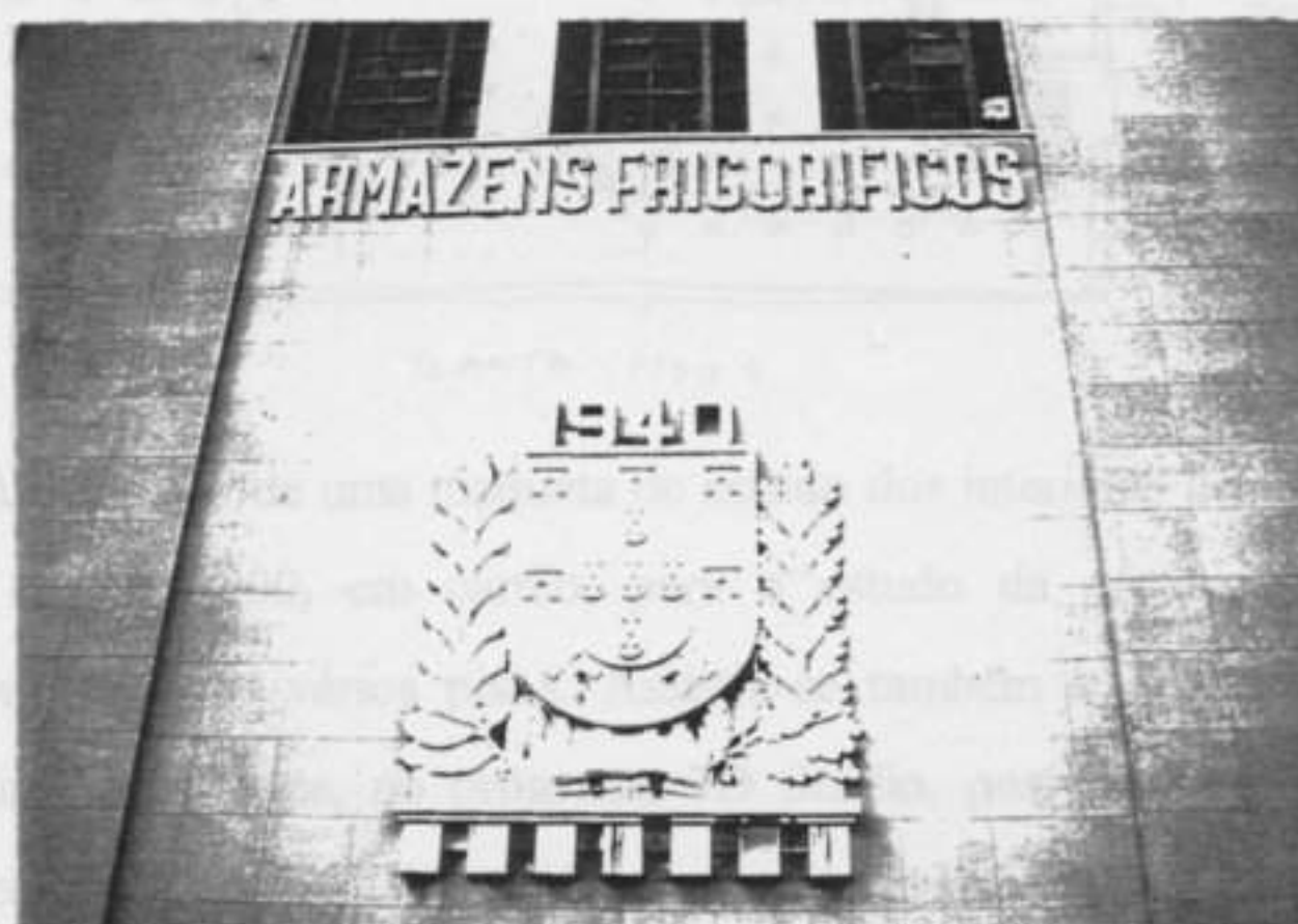
Paínel pétreo na fachada posterior do edifício
