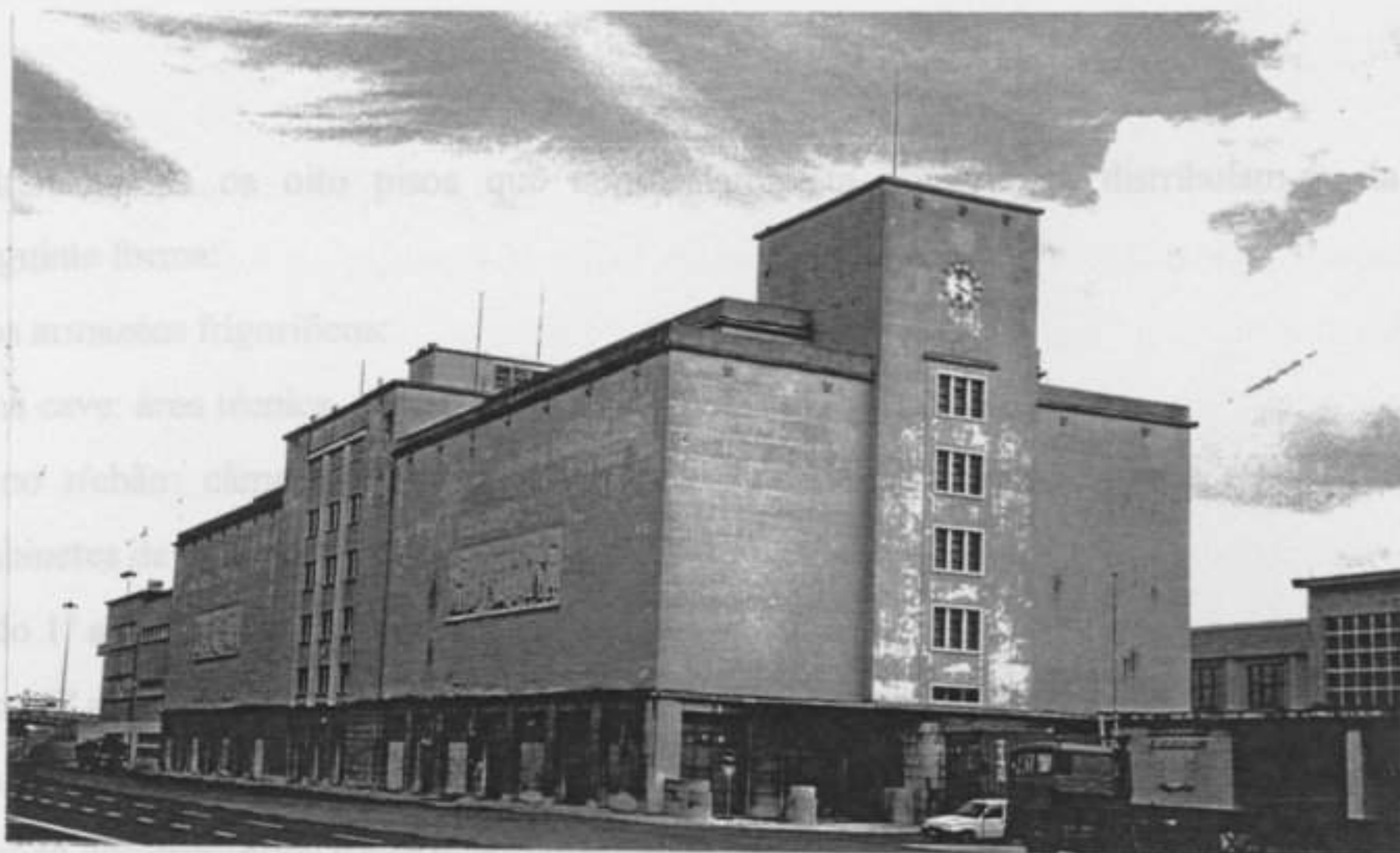
Armazéns Frigoríficos do Bacalhau, frente Av. Brasília
