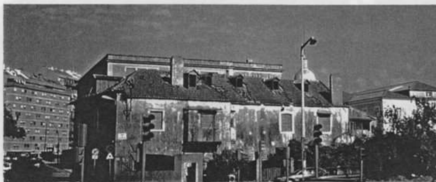
Fachada do edifício frente Av. do Colégio Militar
