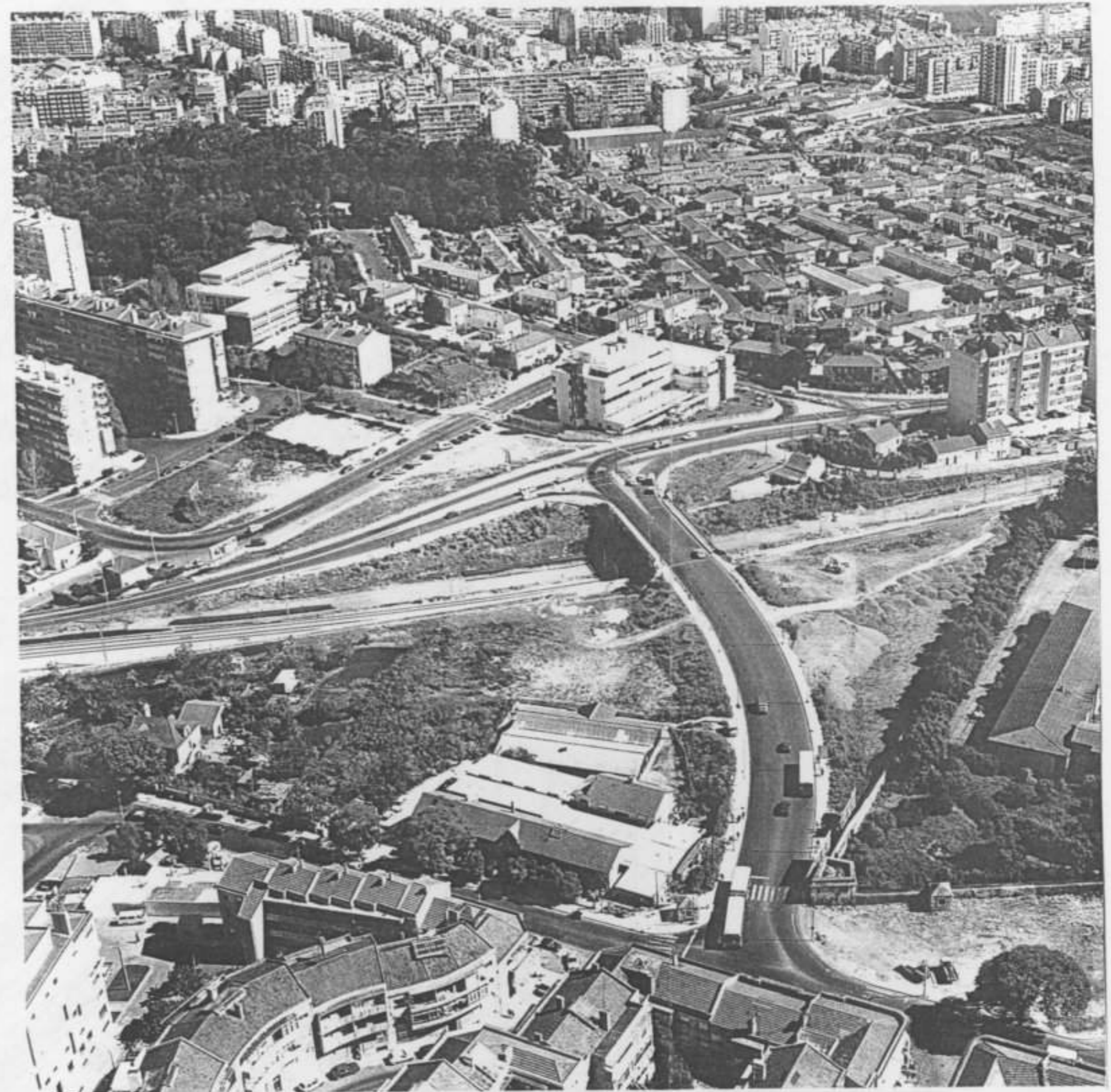
VISTA DO EXISTENTE
