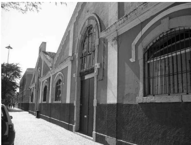
Fig. 1: Casa-atelier Mestre Lagoa Henriques, aspecto do exterior.
