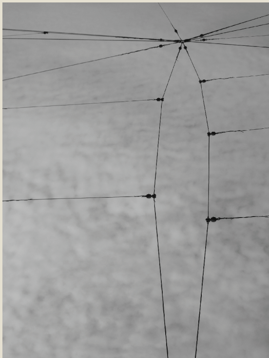
(Fig. 80) Cabos de carros-eléctricos, Lisboa.
