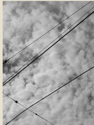
(Fig. 77) Cabos de carros eléctricos, Lisboa.
