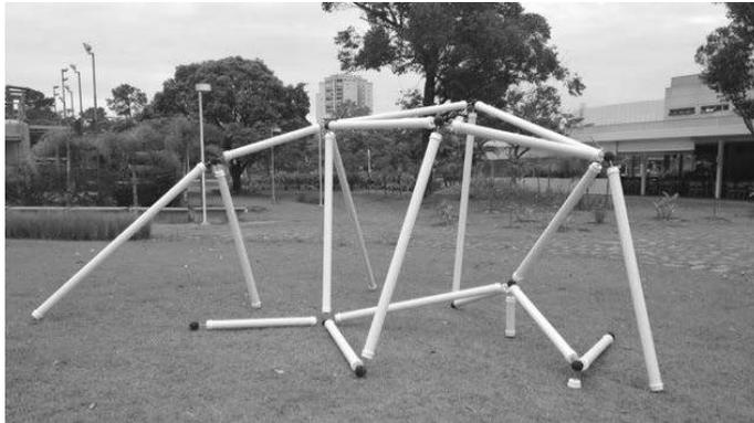
Fig. 16: Micro pavilhão construído no campus. Hastes em tubos de PVC e conexões em resina. (Fonte: Ricardo Silva).
